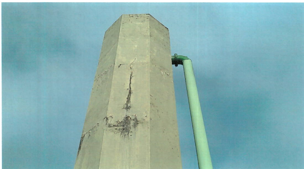
Foto 18: Vazamento de água no TAU.
