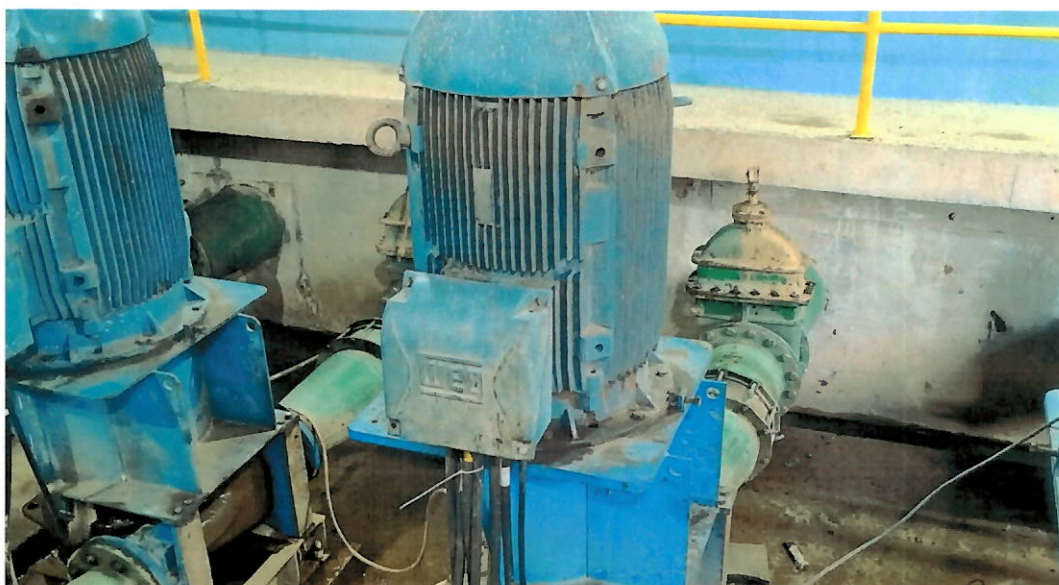
Foto 13: CMB 3 com entrada de ar (será substituído).
