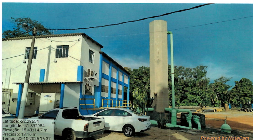
Foto 17: Vista do TAU.
