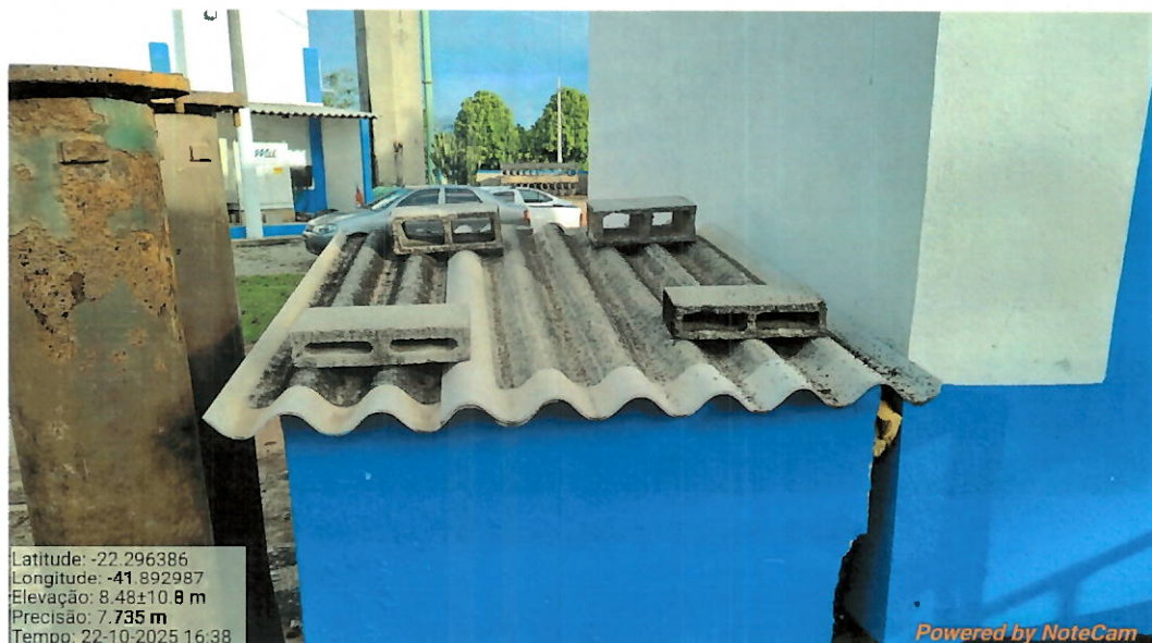
Foto 22: Abrigo construído para caixa de passagem de fiação.
