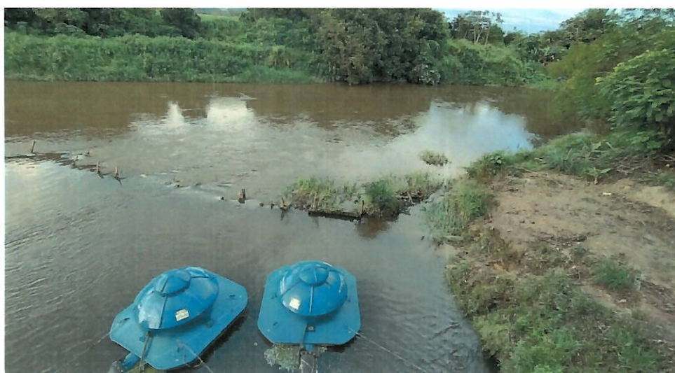
Foto 4: Rio Macaé no ponto de captação (nota-se os módulos flutuantes adquiridos recentemente).
