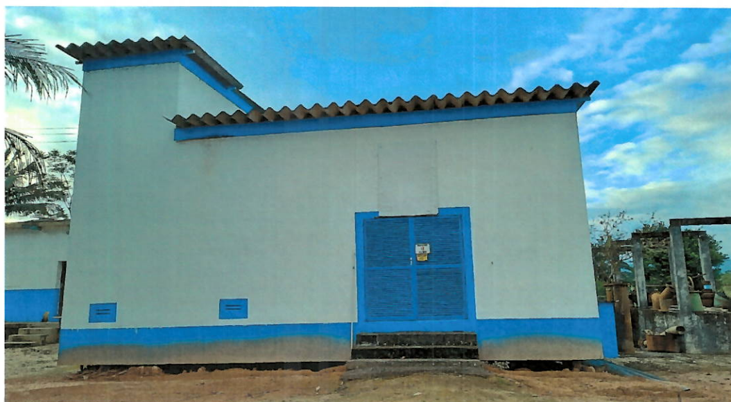
Foto 23: Subestação da unidade.
