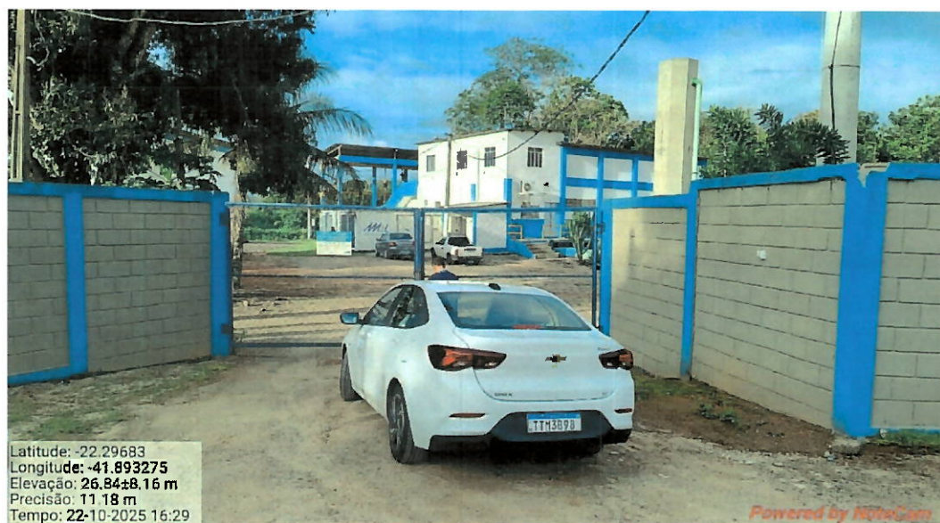
Foto 1: Entrada da Unidade de Captação Severina.
