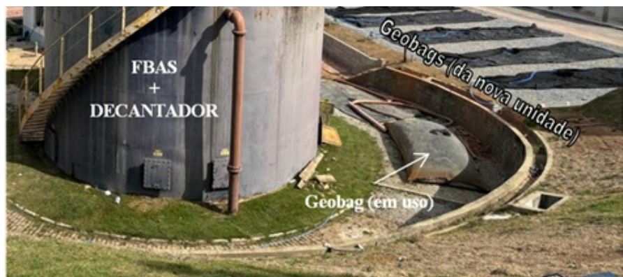
Foto 4 – Tratamento secundário e decantador terciário, geobags para desidratação do lodo
