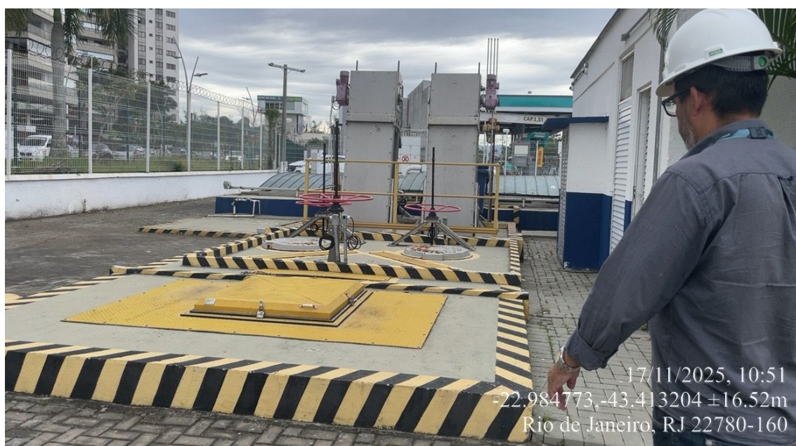
Foto 5 – Poço de chegada do esgoto devidamente coberto
