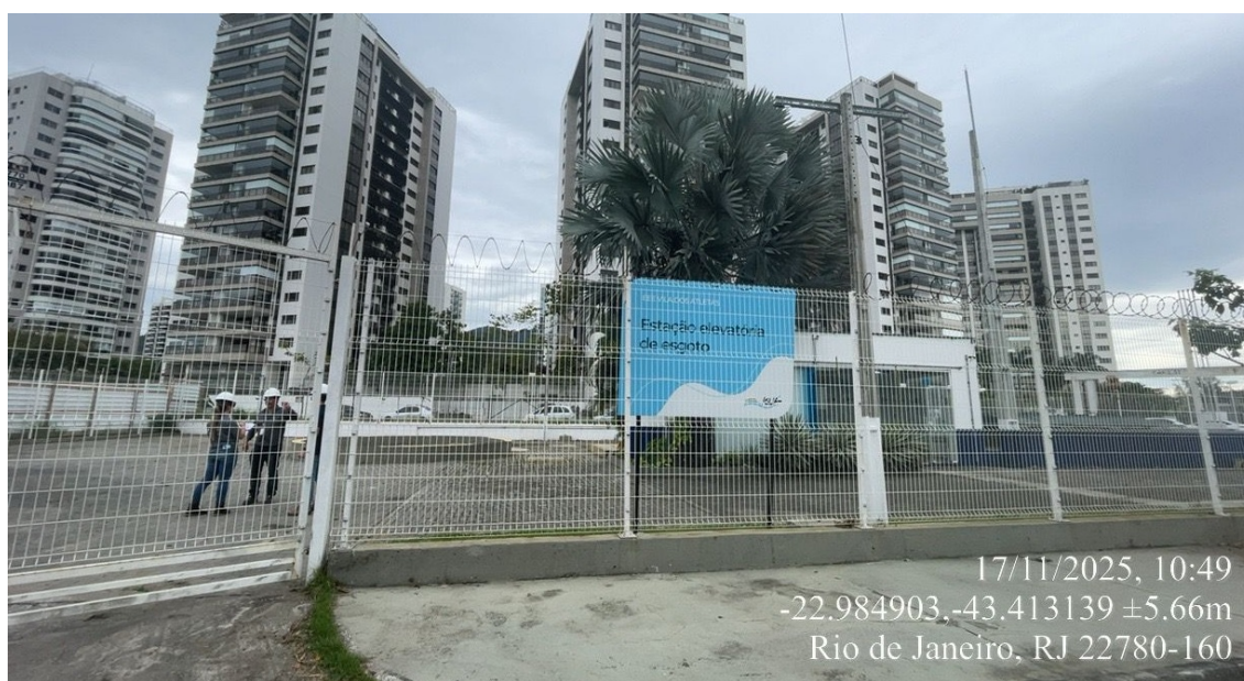
Foto 1 – Identificação da EEEB
