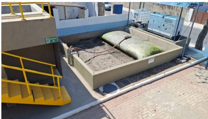
Foto 17 – Lodo armazenado em bags, para drenagem e destinação final. Vista do gerador e do depósito/dosador de PAC para otimizar a sedimentação no decantador.
