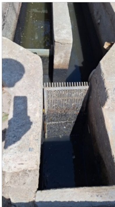
Foto 6 – Gradeamento estático, com limpeza manual.
