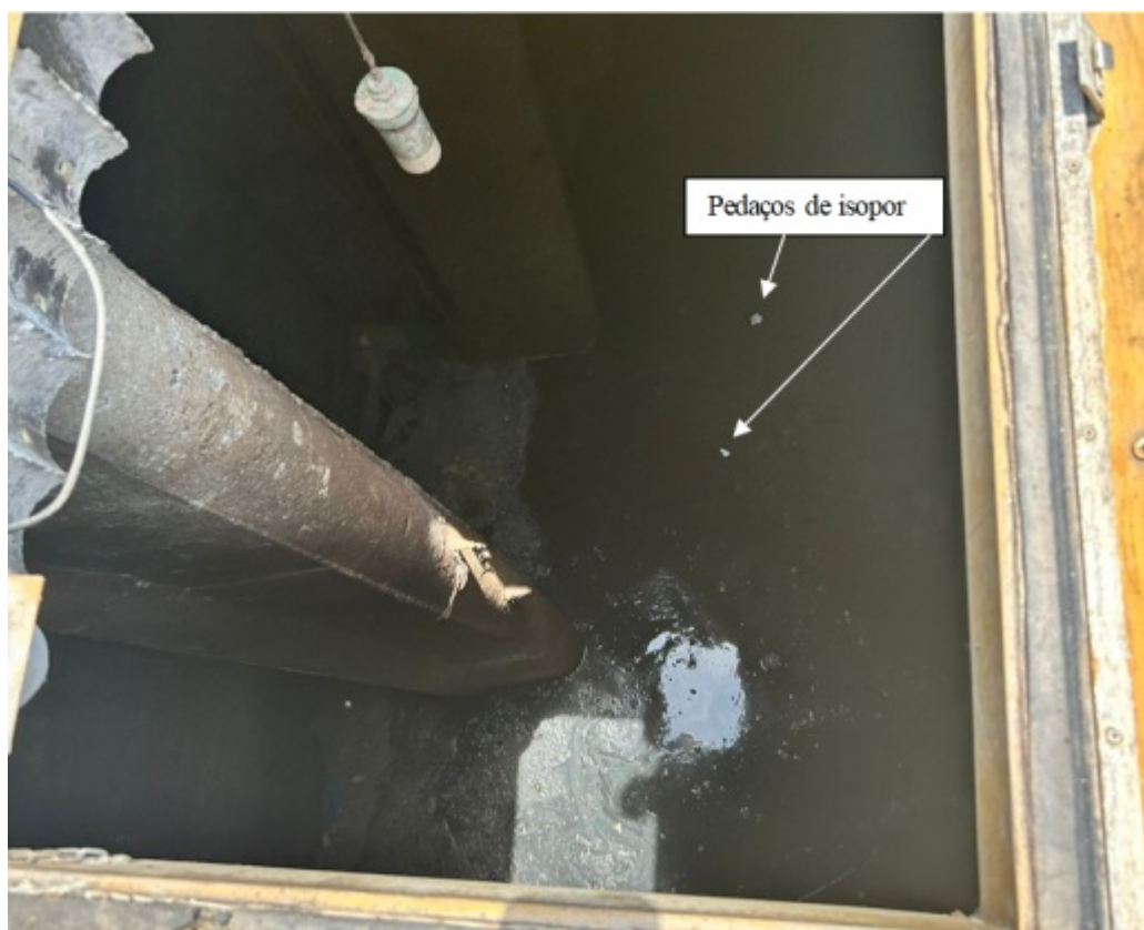
Foto 29 – Interior caixa de chegada do esgoto
