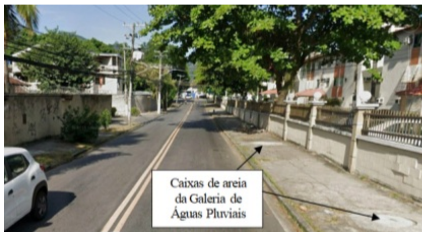
Foto 2 – Galeria de Águas Pluviais no passeio público da estrada Caribú
