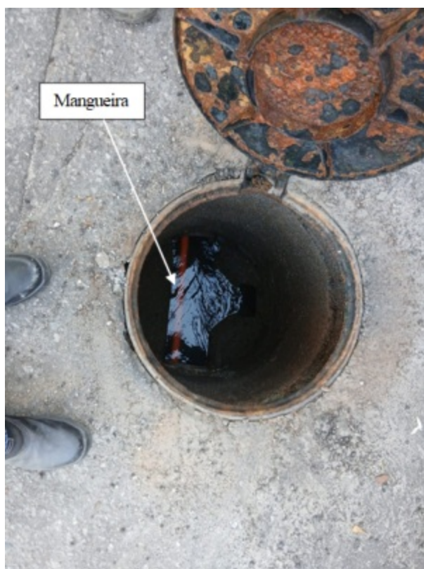
Foto 8 – Água pressurizada inserida através de uma mangueira
