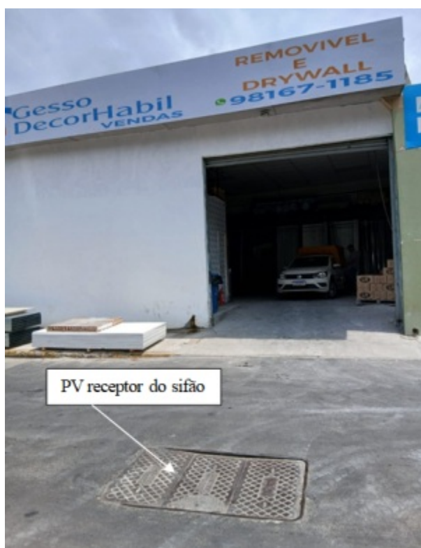
Foto 10 – PV receptor do sifão localizado na Avenida Canal do Anil
