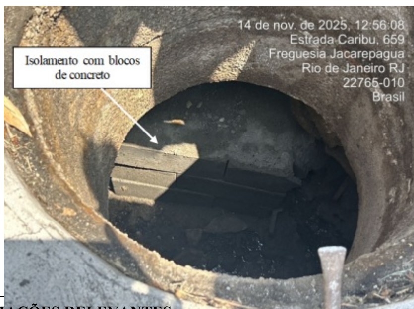
Foto 30 – Caixa de areia na GAP da Estrada Caribú
