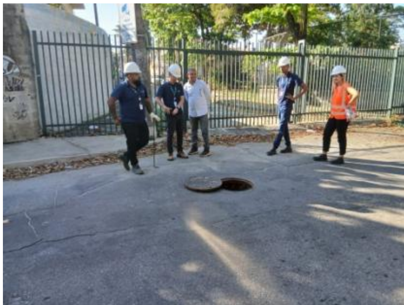
Foto 5 – PV localizado na esquina da Rua Oswaldo Santiago com Avenida Canal do Anil
