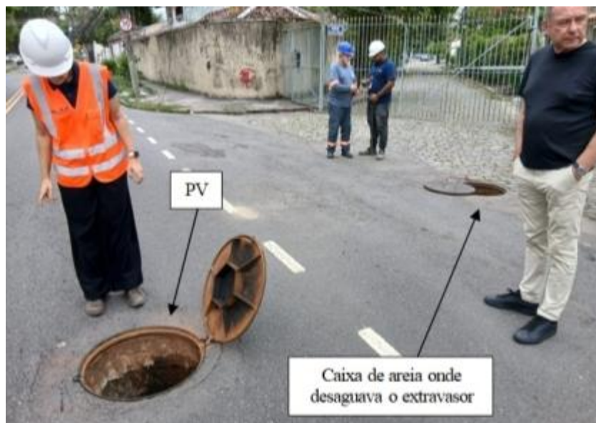
Foto 16 – PV onde existia um extravasor
