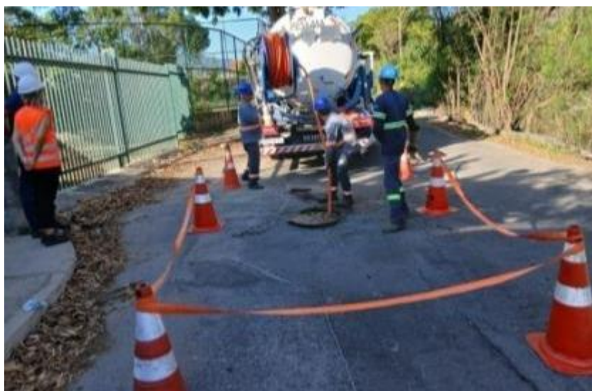
Foto 6 – Caminhão de esgoto com água pressurizada
