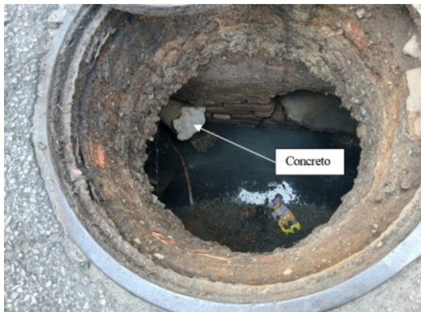
Foto 17 – Extravasor tamponado com concreto
