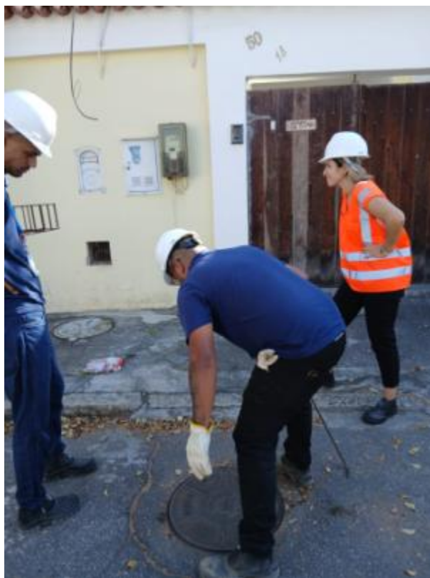
Foto 4 – PV localizado em frente ao nº 50 da Rua Oswaldo Santiago
