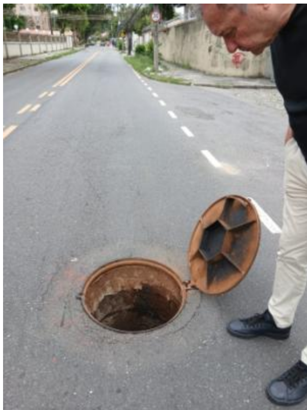
Foto 1 – PV da Rede de Esgotos Sanitários (RES) localizado na estrada Caribú
