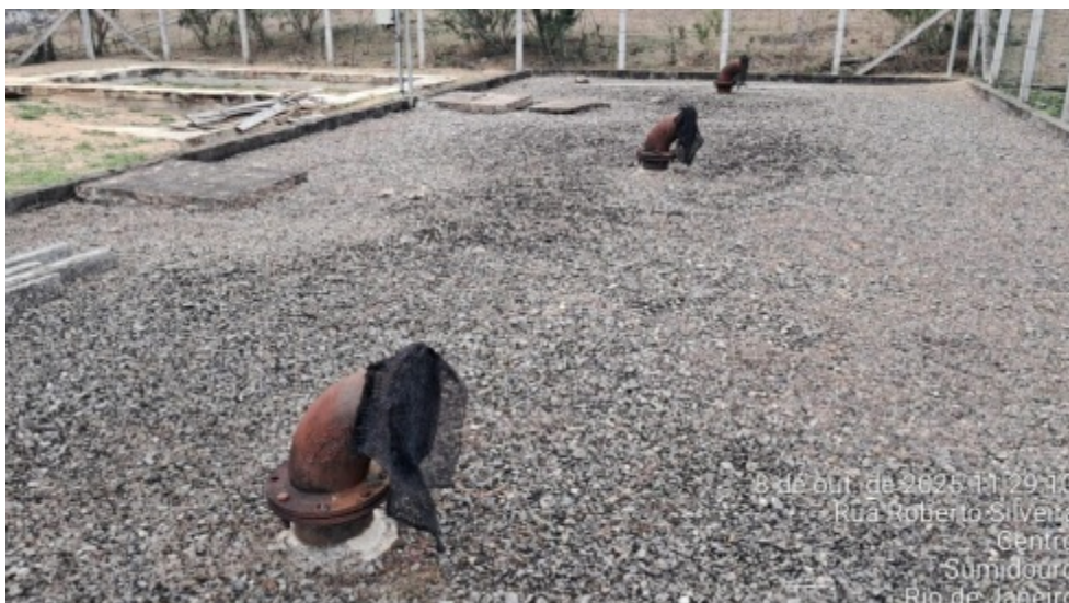
Foto 21 – Visualização da laje do reservatória e janelas de ventilação protegidas
