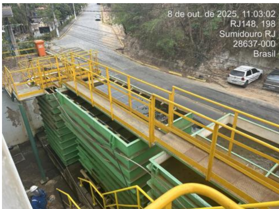
Foto 6 – Visualização dos tanques da ETA e guarda-corpo em bom estado
