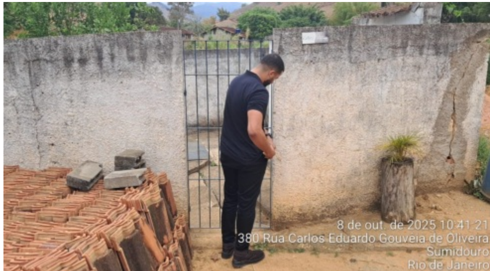
Foto 2 – Entrada do acesso a caixa de armazenamento
