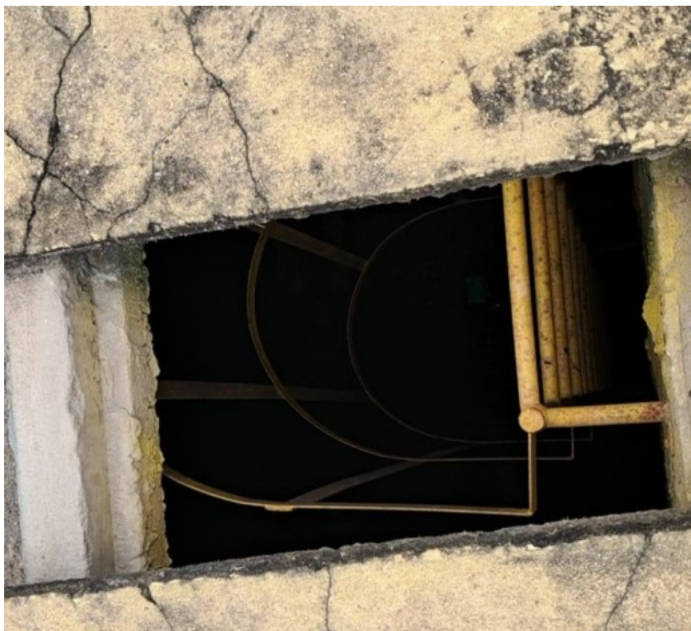
Foto 20 – Escada de acesso
