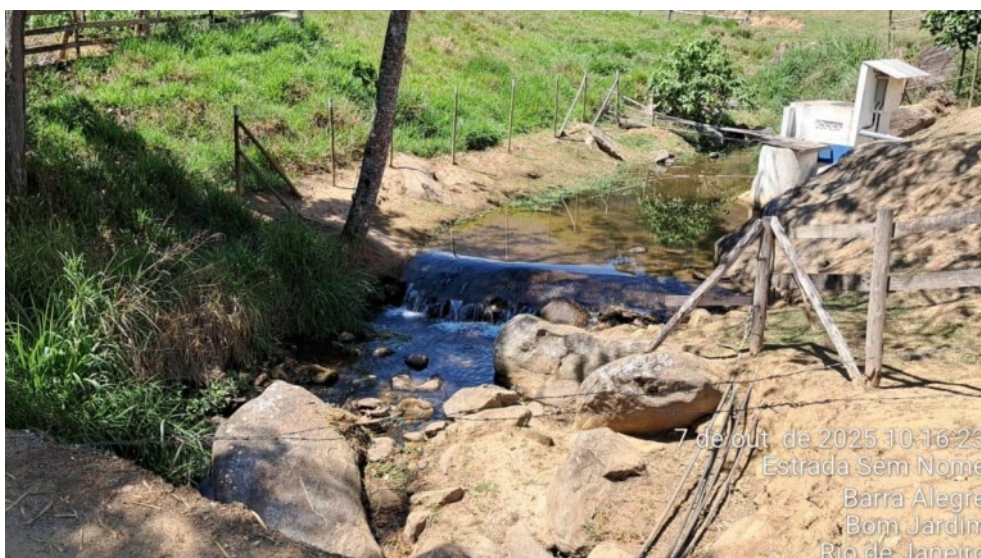
Foto 1 – Barragem de nível da captação
