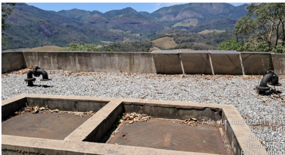
Foto 30 – Laje do reservatório
