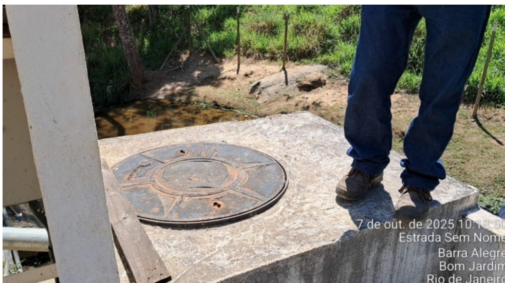
Foto 4 – Abrigo da motobomba
