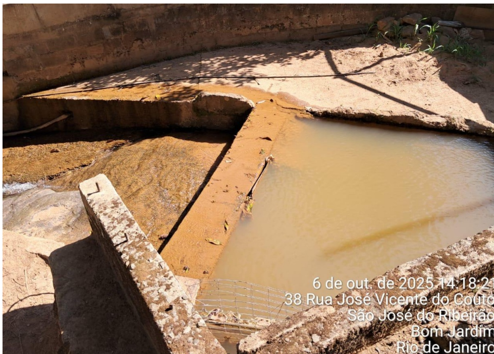
Foto 1 – Barragem de nível da captação
