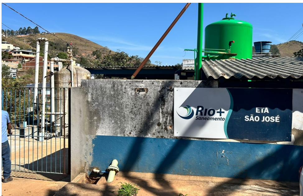
Foto 3 – Entrada da ETA São José
