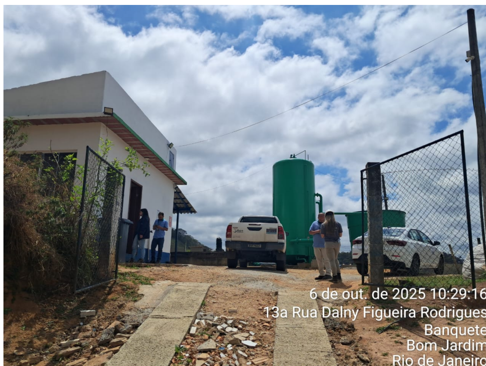
Foto 7 – Entrada da ETA Banquete
