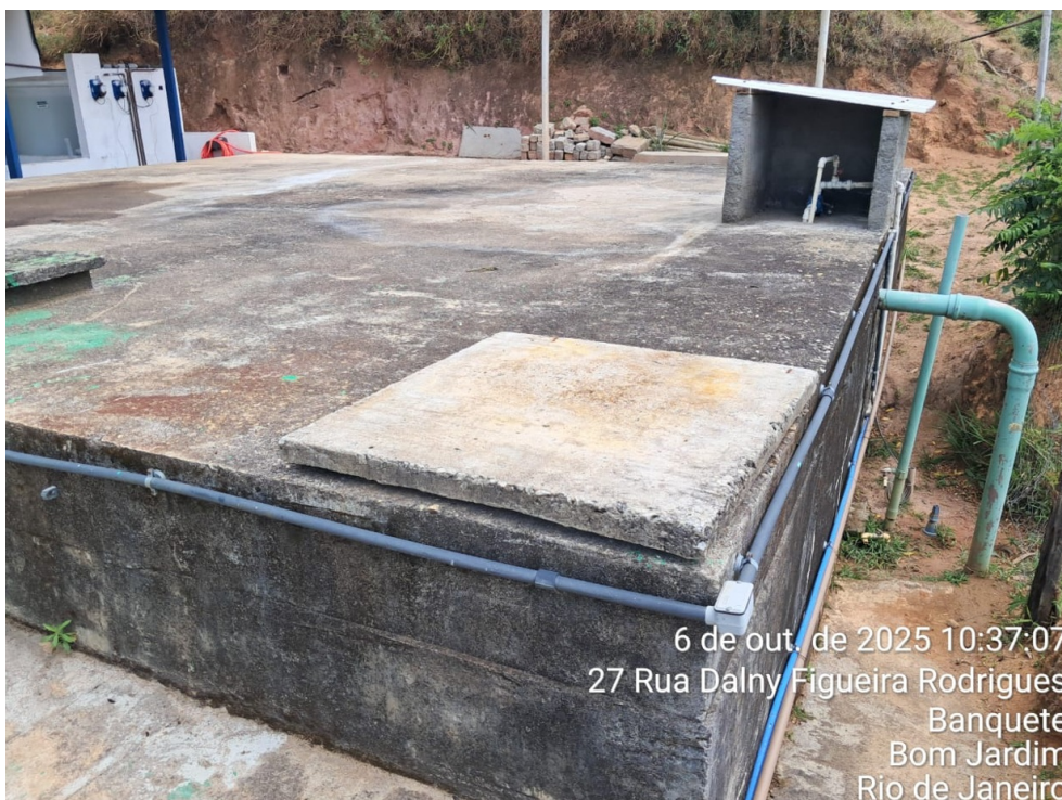
Foto 16 – Reservatório existente na ETA
