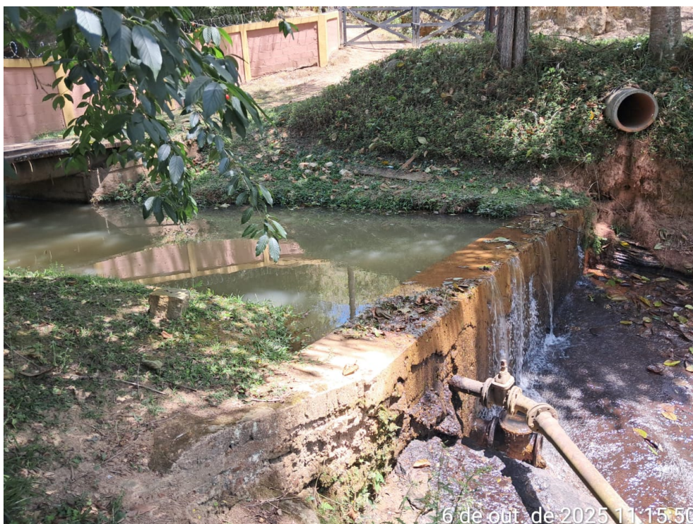
Foto 5 – Barragem de nível da captação
