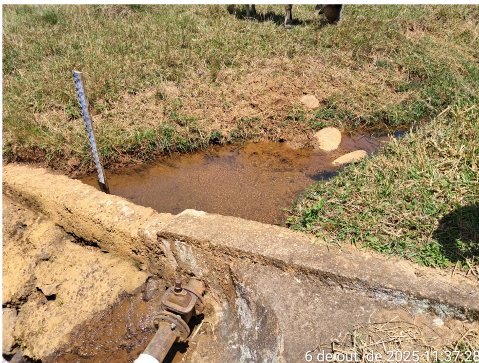
Foto 1 – Barragem de nível da captação
