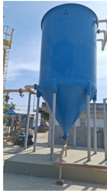
Foto 14 e 15 – Efluente tratado vai para o decantador que não recircula o lodo para o reator, que vai a partir do fundo para tanque de lodo por gravidade, e porconsequinte o efluente tratado ascende até a tubulação superior, que escoa para deságüe.
