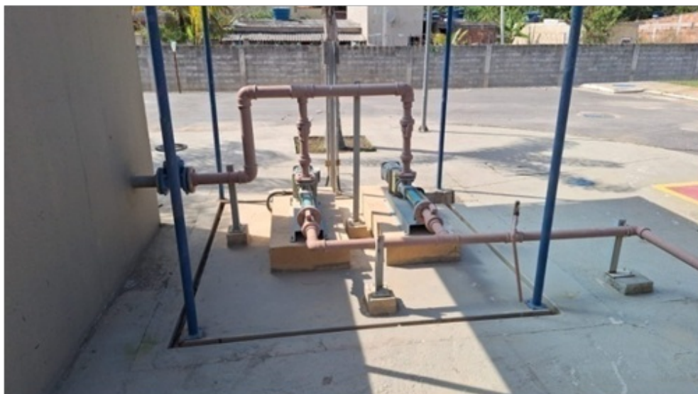
Foto 16 – Tubulações de descarga do lodo do decantador final chegando ao tanque de lodo.
