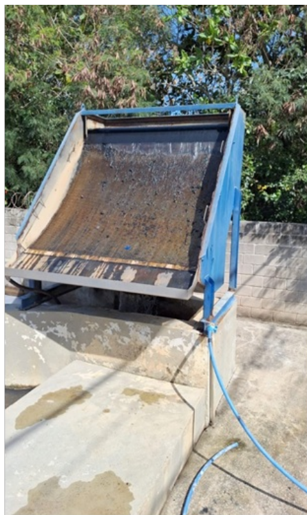
Foto 5 – Gradeamento estático, com limpeza manual.
