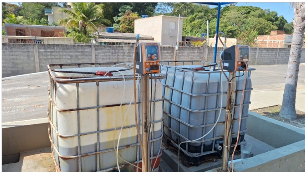
Foto 8 -Depósito, preparação e dosagem do coagulante PAC (policloreto de alumínio), dosagem no desarenador.
