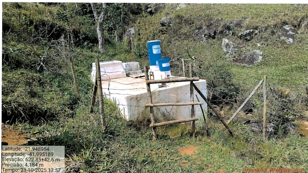
Foto 2: UT Dubois (área cercada por arames).
