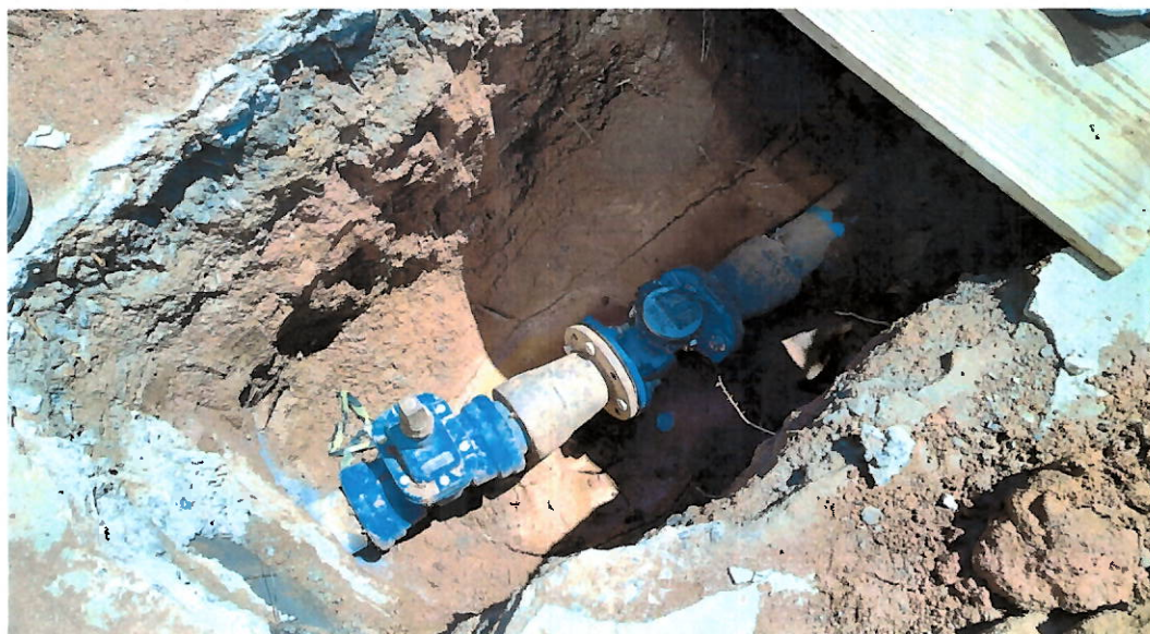
Foto 7: Macromedidor instalado na saída da ETA.
