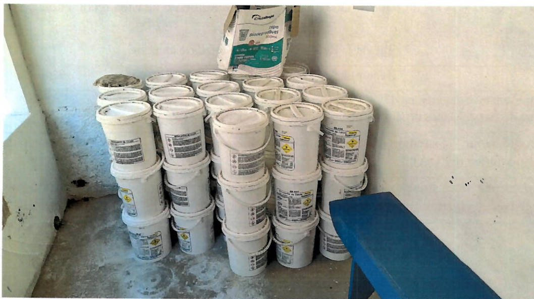
Foto 18: Armazenamento inadequado de hipoclorito de cálcio.
