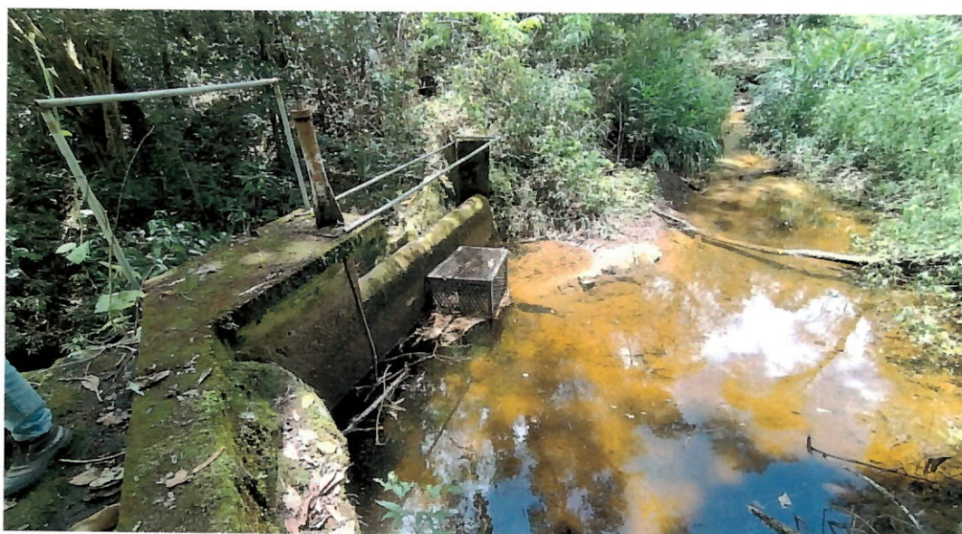
Foto 2: Ponto de captação – barragem com grade em boas condições.
