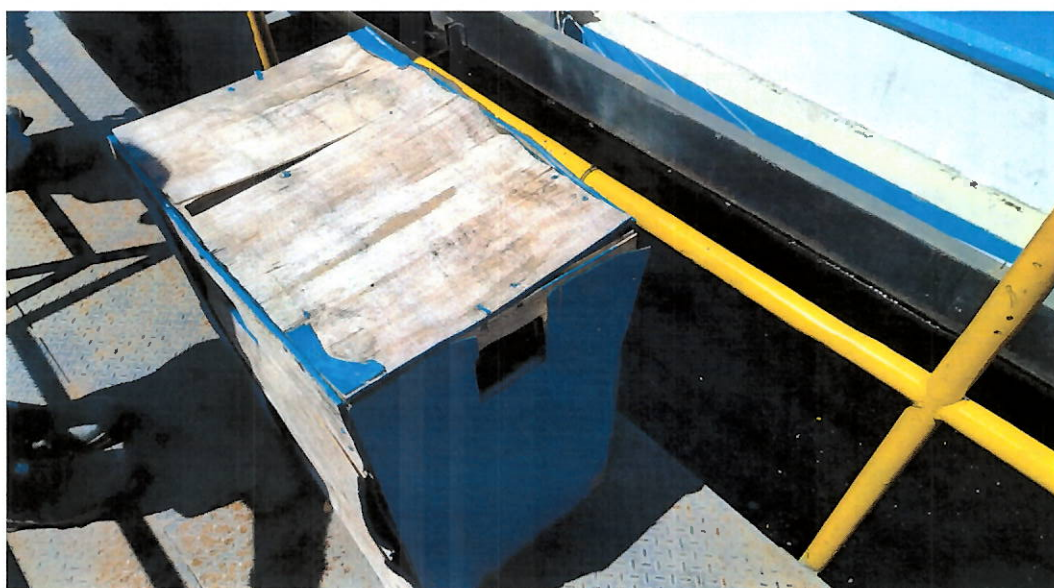
Foto 10: Abrigo da bomba do agitador.
