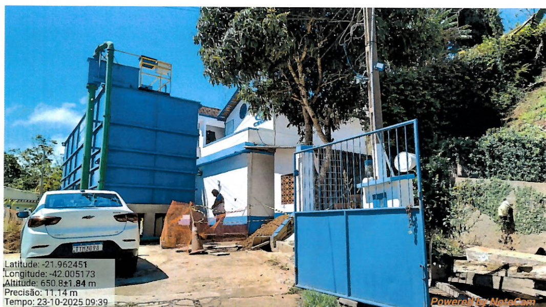
Foto 4: Entrada da ETA.
