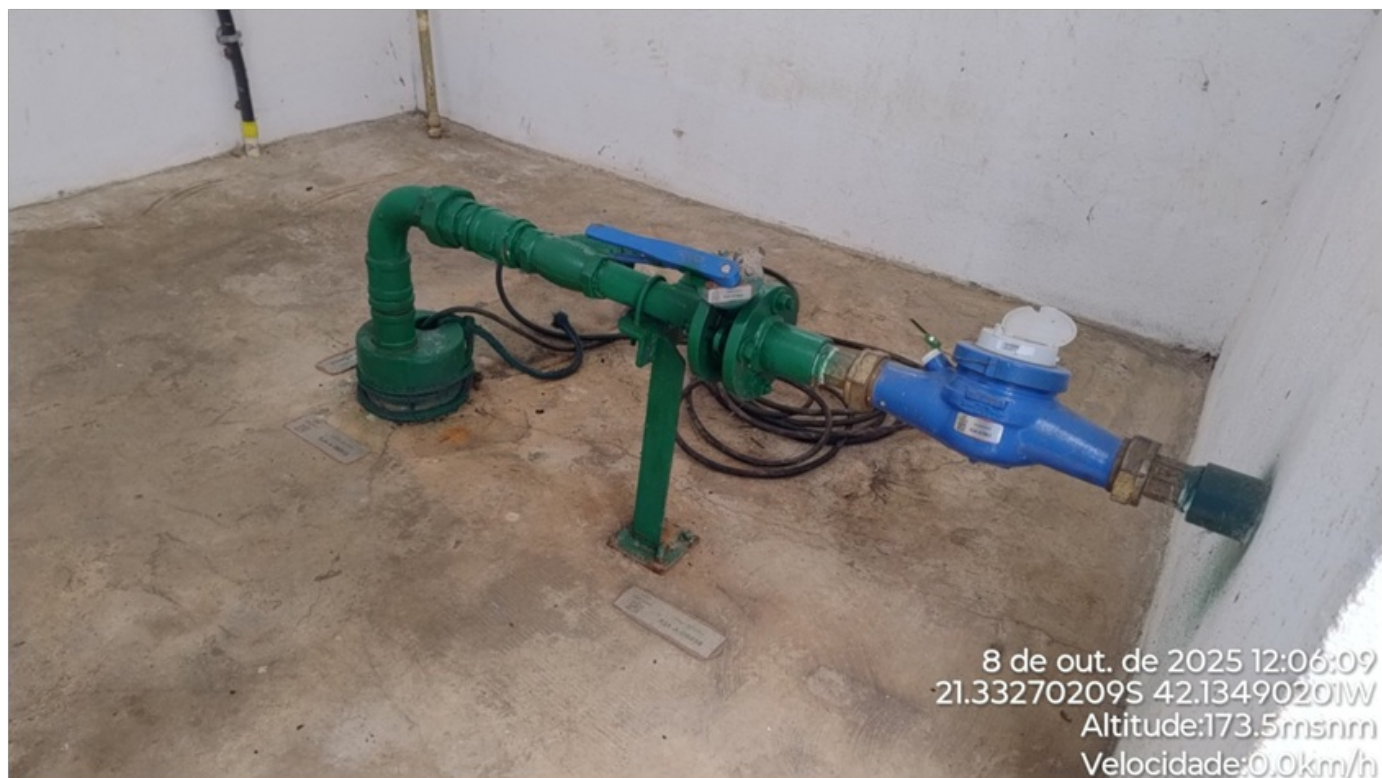
Foto 03: Barrilete do poço.
