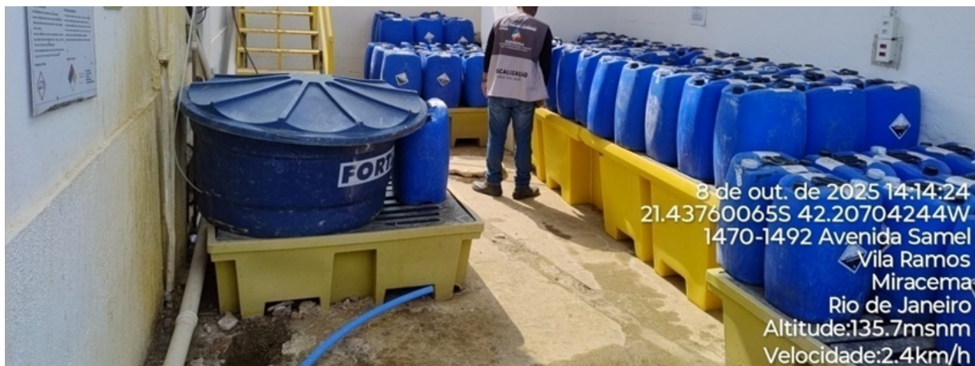
Foto 13: Dosador de Sulfato de alumínio (agente coagulante).
