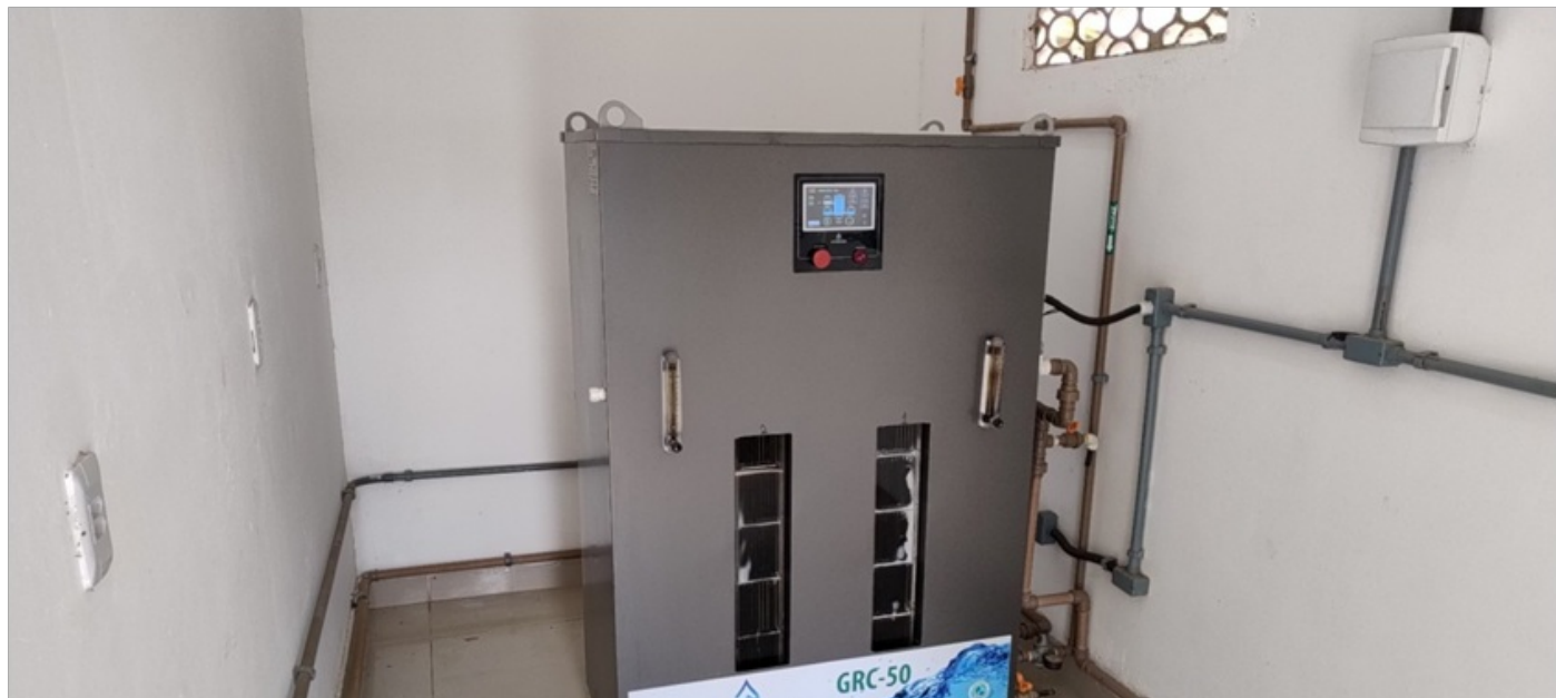
Foto 14: Dosador de ácido fluossilícico.
