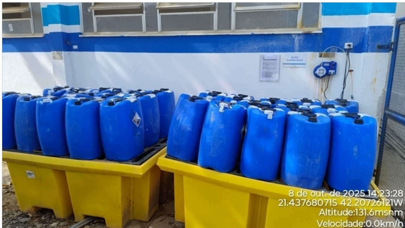
Foto 14: Dosador de ácido fluossilícico.
