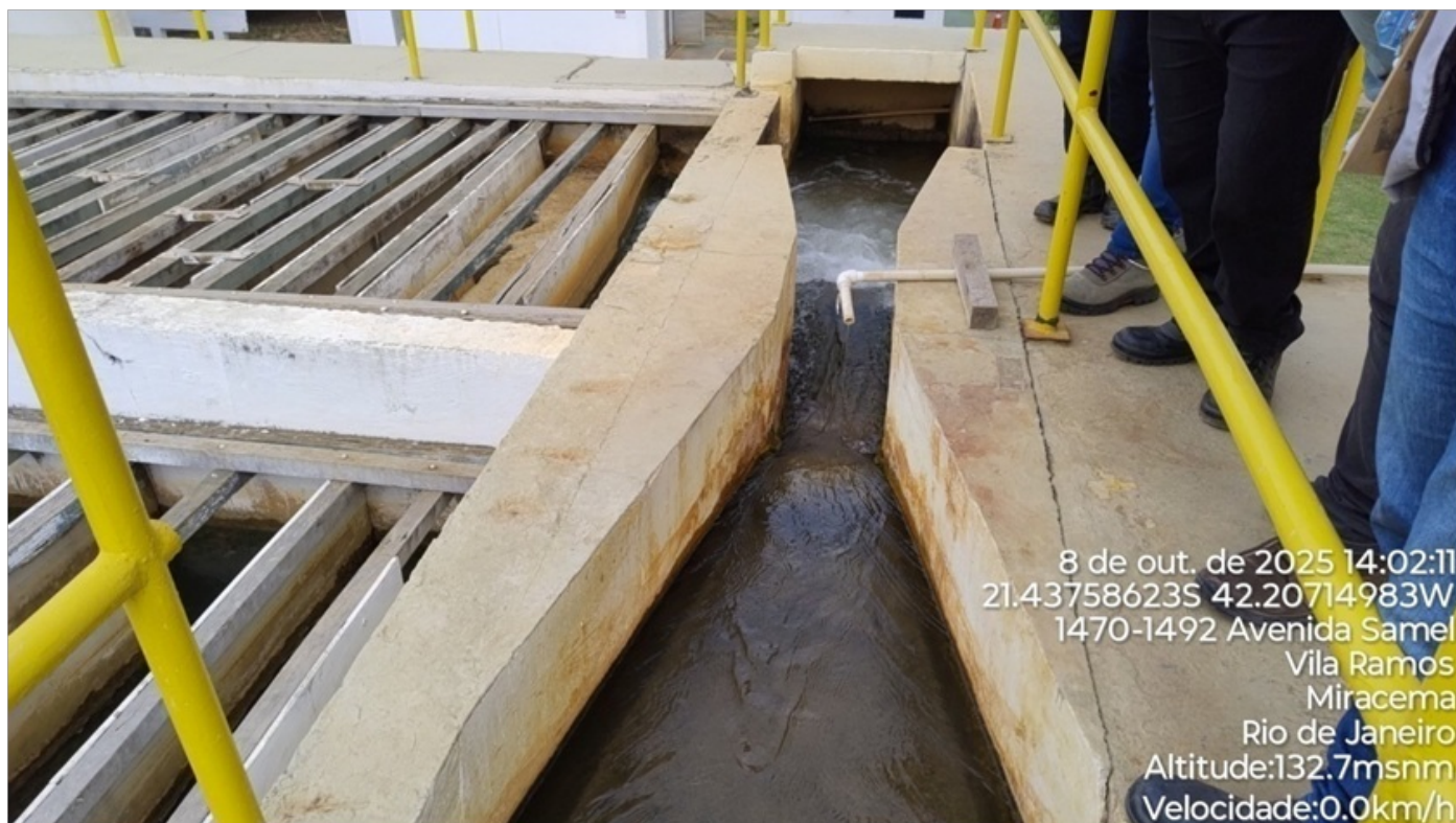
Foto 06: Calha Parshall e aplicação do agente coagulante.
