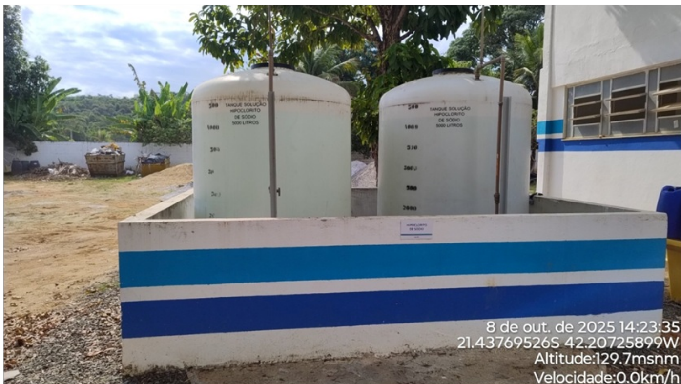
Foto 17: Armazenamento do Hipoclorito de sódio.
