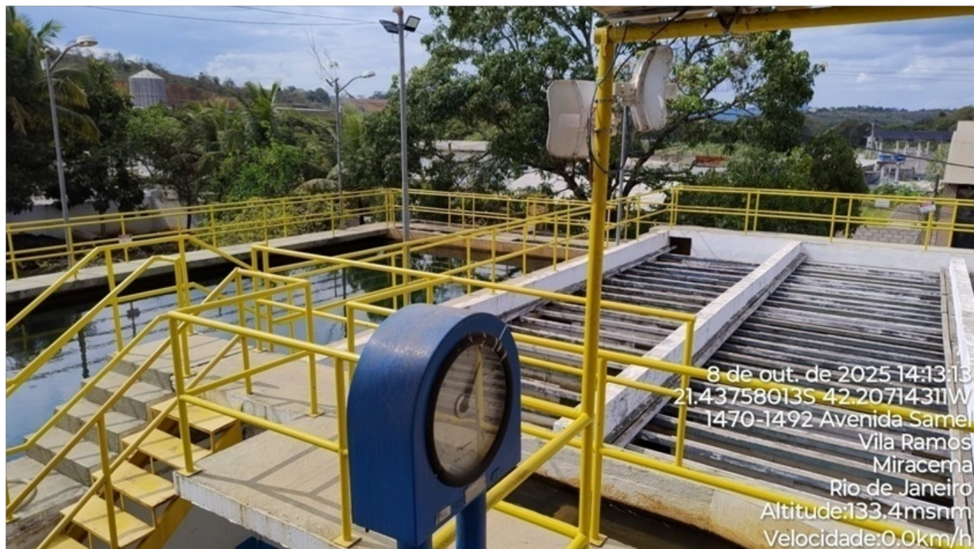
Foto 04: Vista geral do módulo de tratamento.
