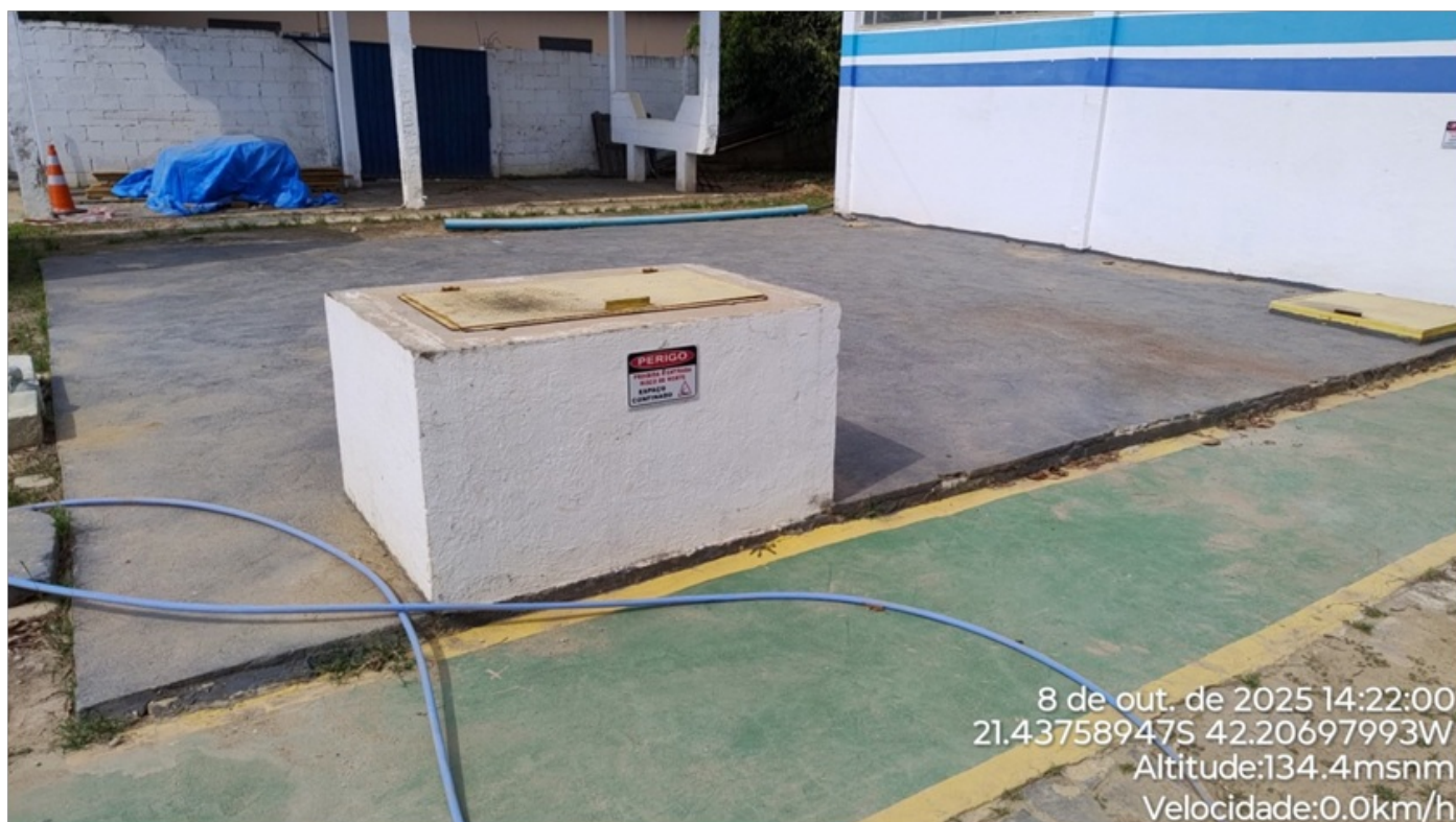
Foto 19: Cisterna de reservação de água tratada.
