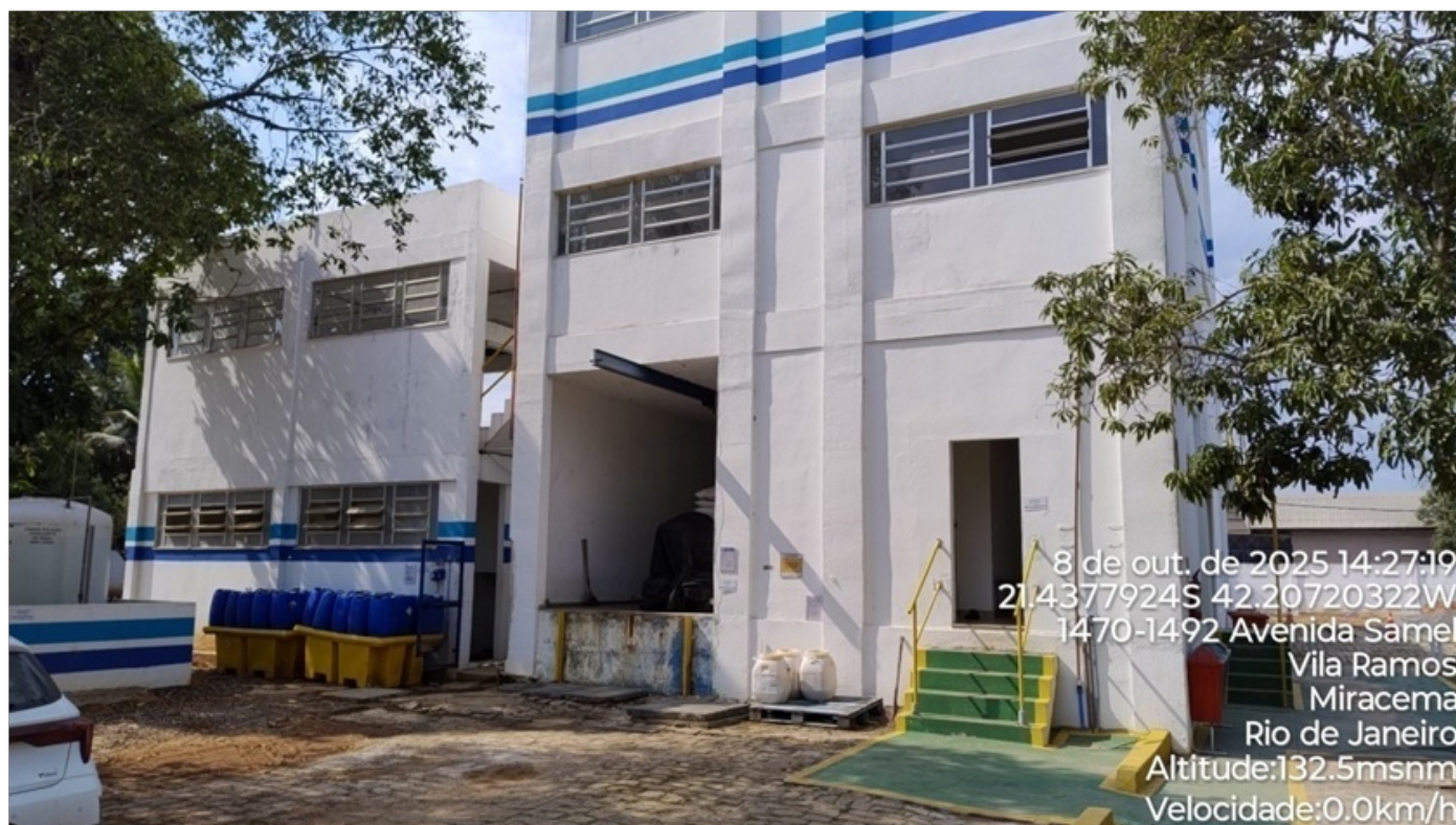
Foto 01: Entrada da ETA.
