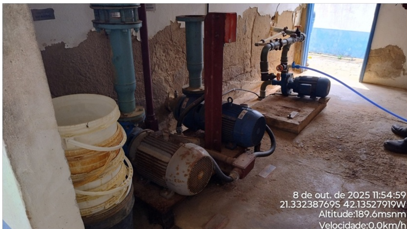
Foto 15: Bombas da elevatória de água tratada e lavagem do filtro.
