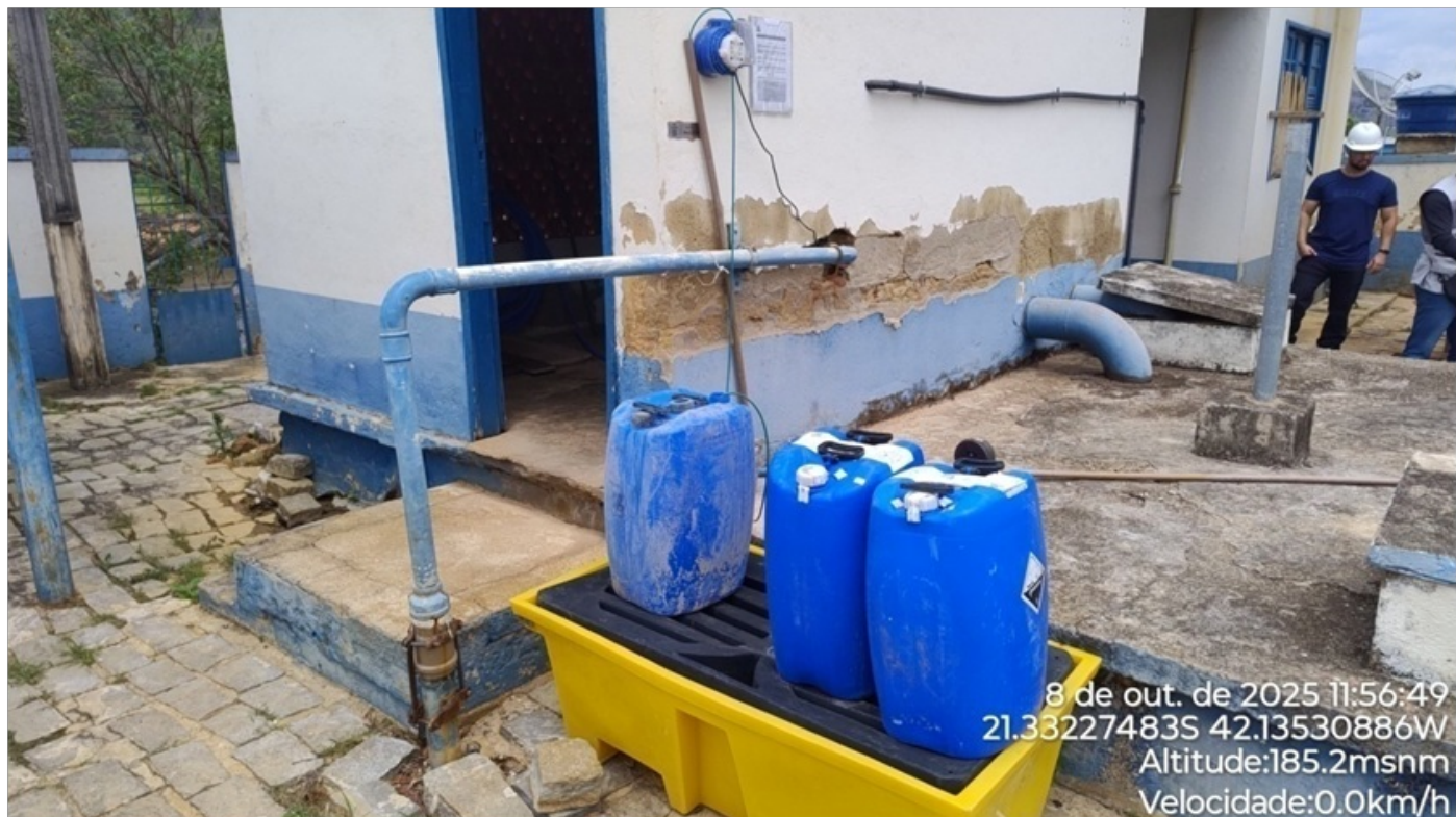
Foto 17: Dosador de ácido fluossilícico.
