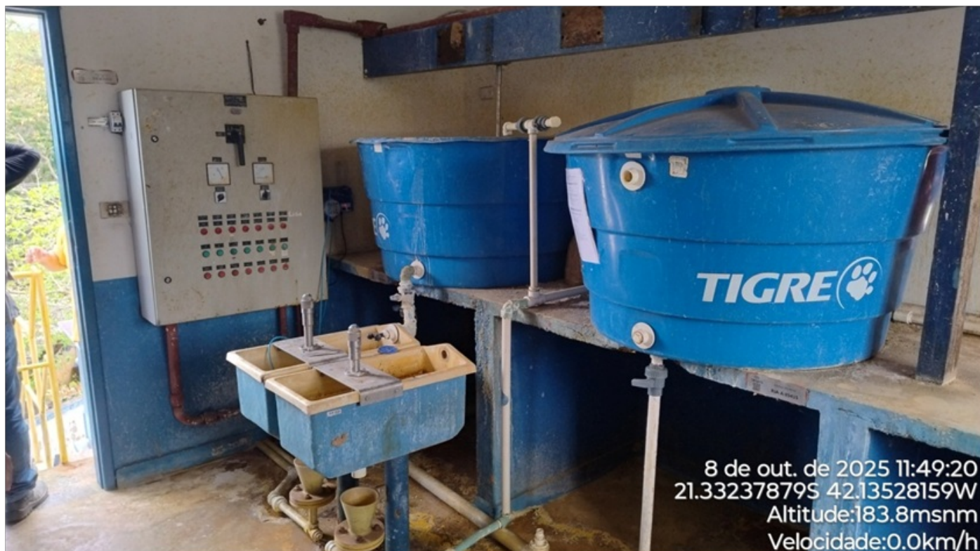
Foto 10: Dosador de Sulfato de alumínio (agente coagulante).
