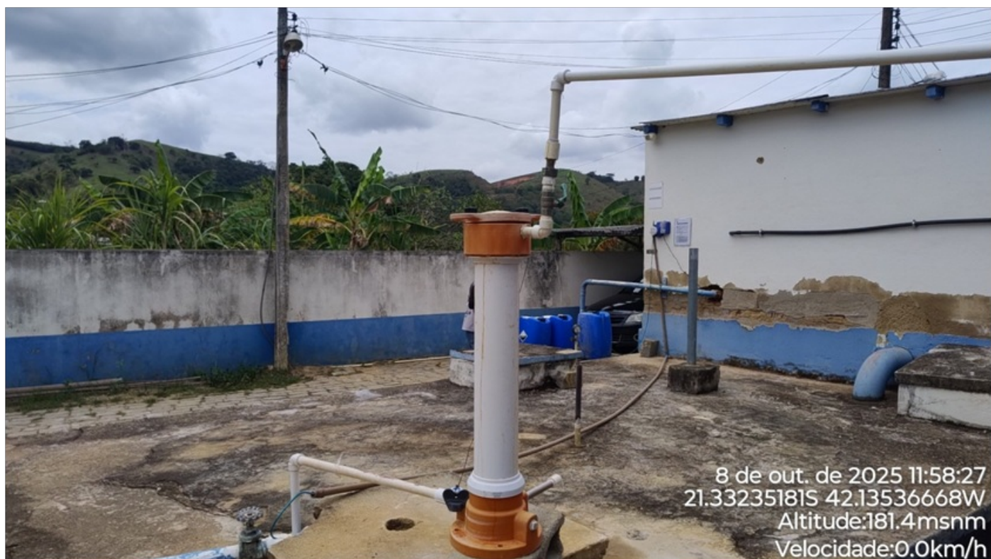
Foto 18: Equipamento de cloração.
