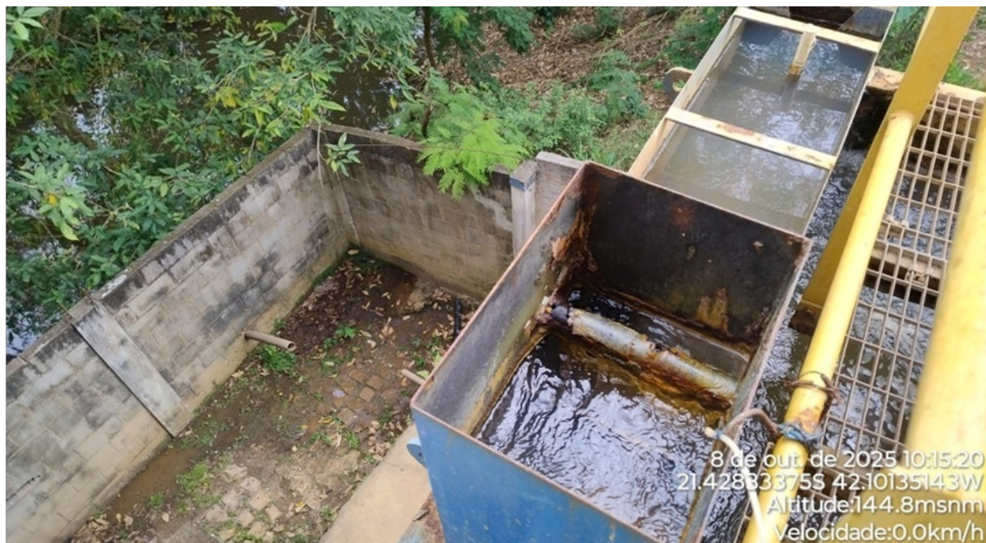
Foto 07: Calha Parshall e aplicação do agente coagulante.
