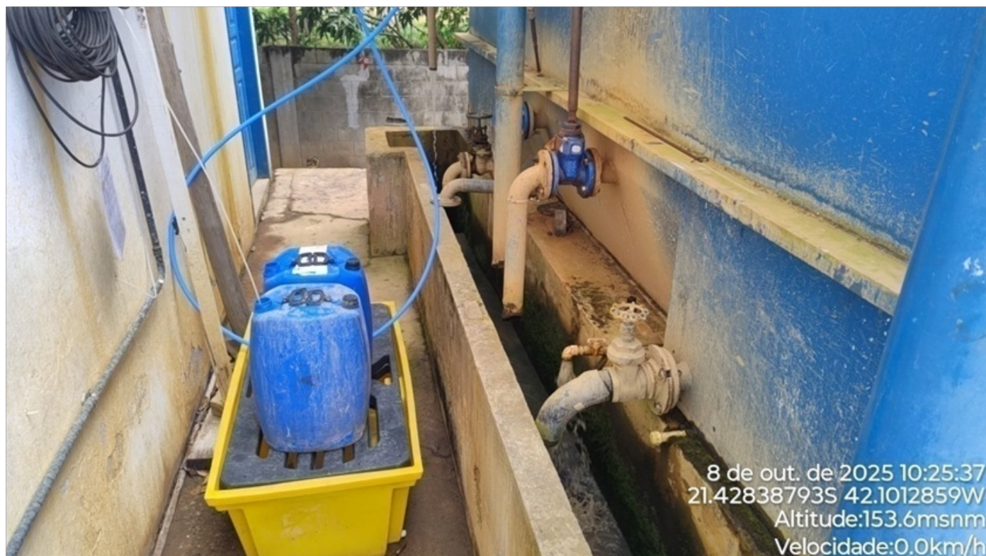
Foto 12: Vista lateral do módulo de tratamento e válvulas manuais de manobra.
