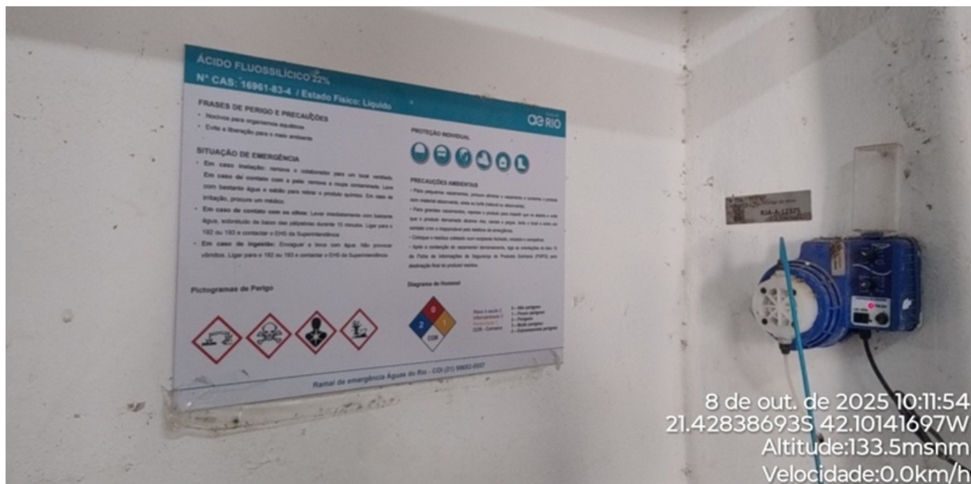
Foto 18: Dosador de ácido fluossilícico.
