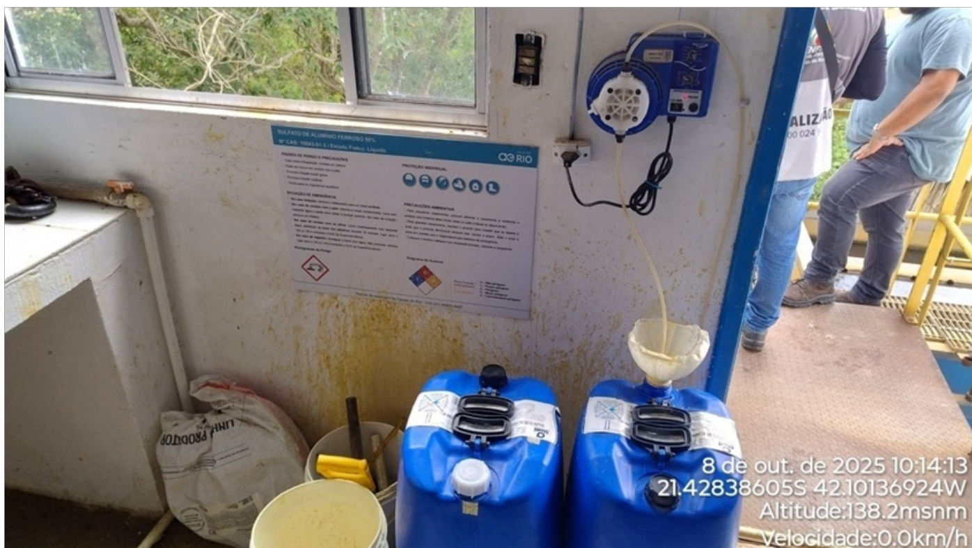
Foto 17: Dosador de Sulfato de alumínio (agente coagulante).
