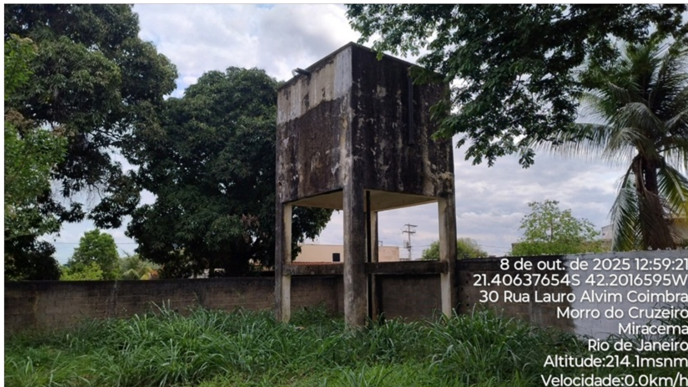
Foto 02: Vista do reservatório.
