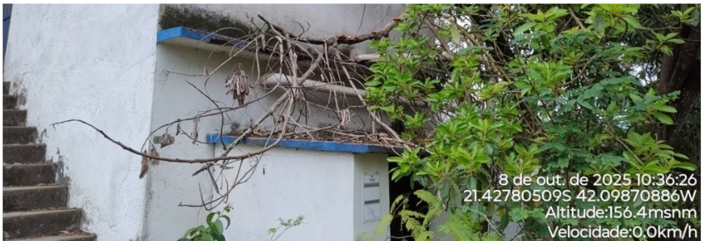
Foto 04: Vista do reservatório.
