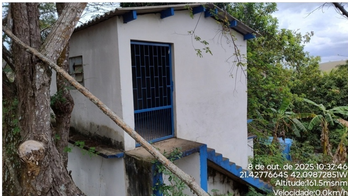
Foto 02: Vista lateral do reservatório.
