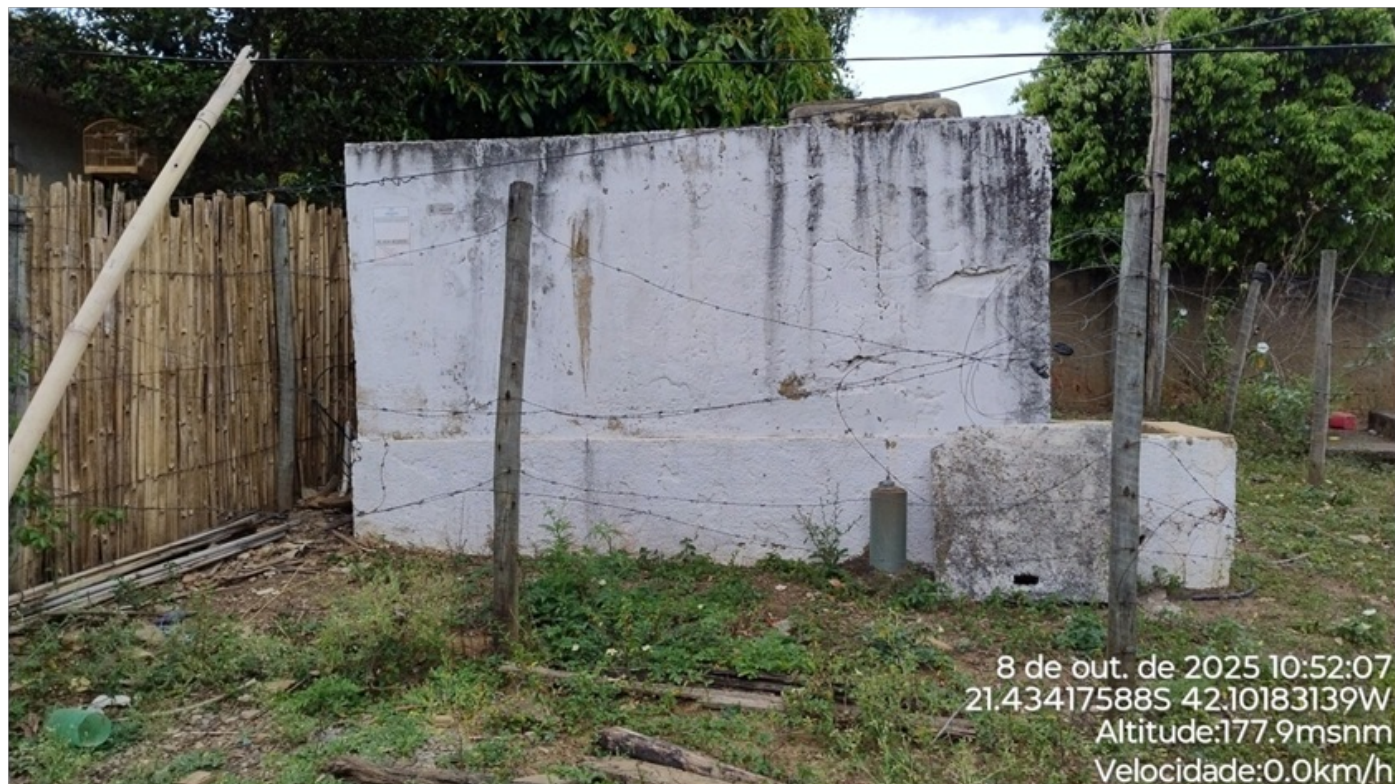
Foto 02: Vista lateral do reservatório.
