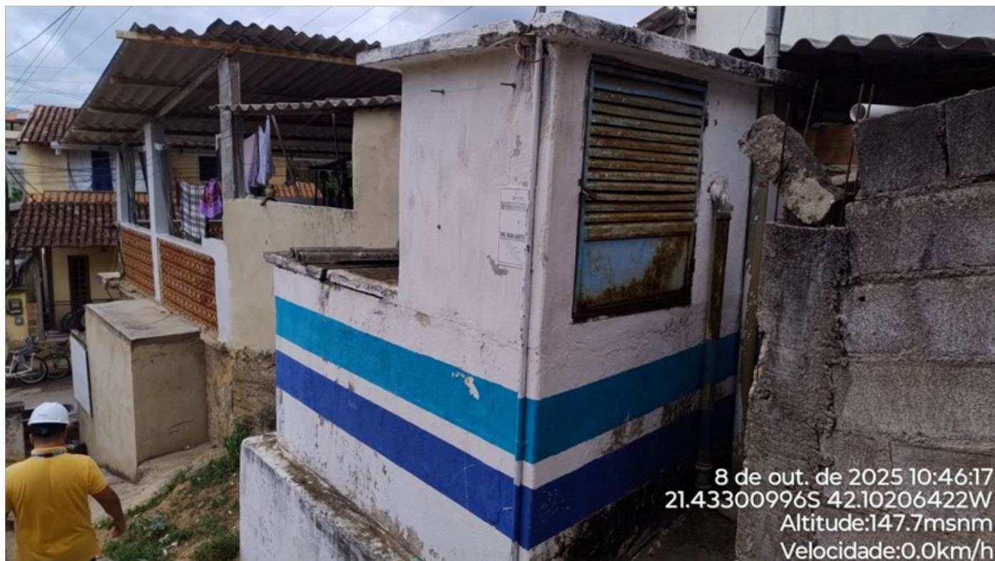
Foto 02 – Abrigo da EEAT com restrição de acesso.
