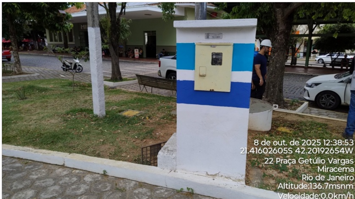
Foto 02 – Abrigo do medidor de energia elétrica da EEAT.
