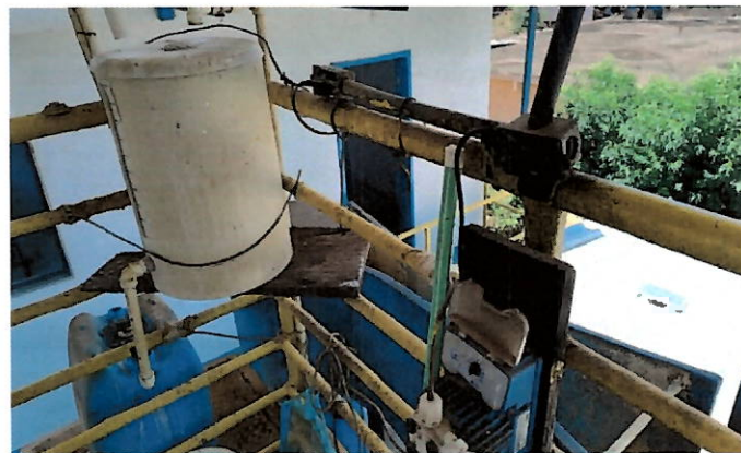
Foto 6: Ponto de aplicação de sulfato de alumínio.
