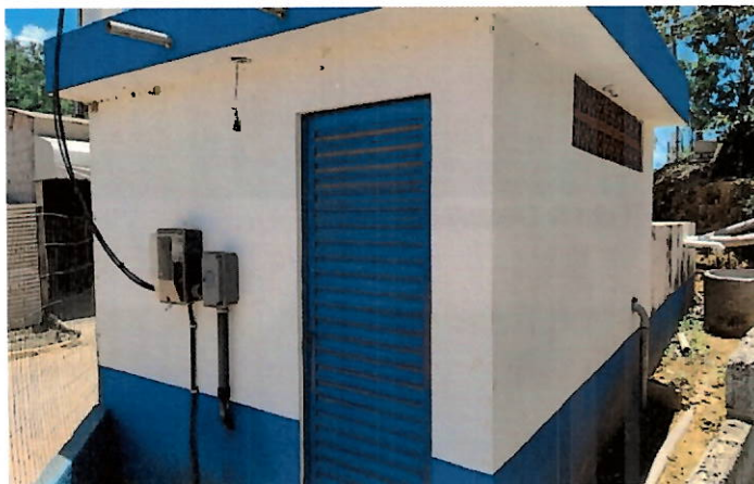
Foto 12: Estação elevatória de água tratada.
