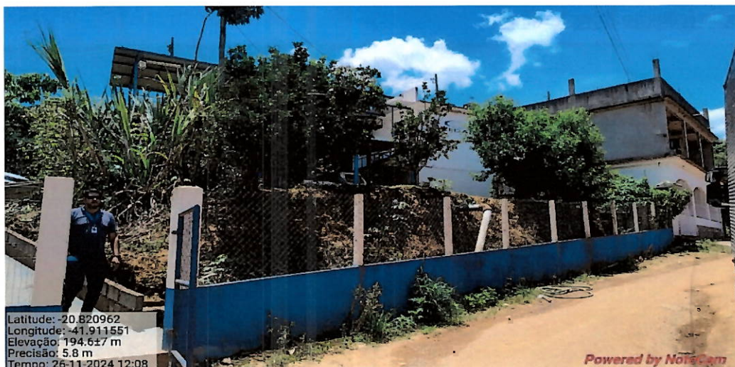
Foto 4: Entrada ETA. Nota-se a ausência da placa de identificação da ETA.
