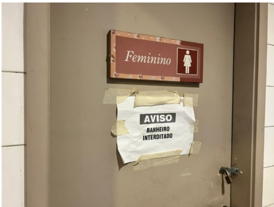
Foto 4. Banheiro feminino interditado no 5º andar.
