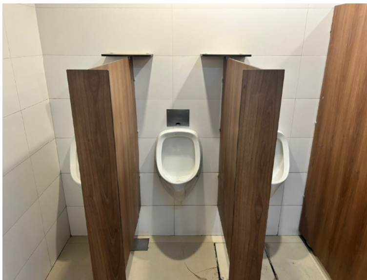
Foto 9. Banheiro masculino no térreo.
