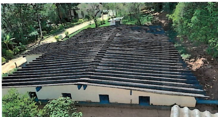
Foto 14: Reservatório de abastecimento.
