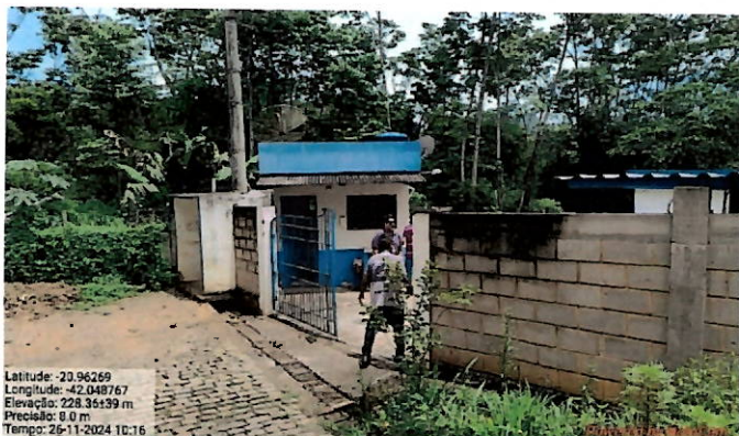
Foto 1: Captação – nota-se a ausência de placa de identificação
