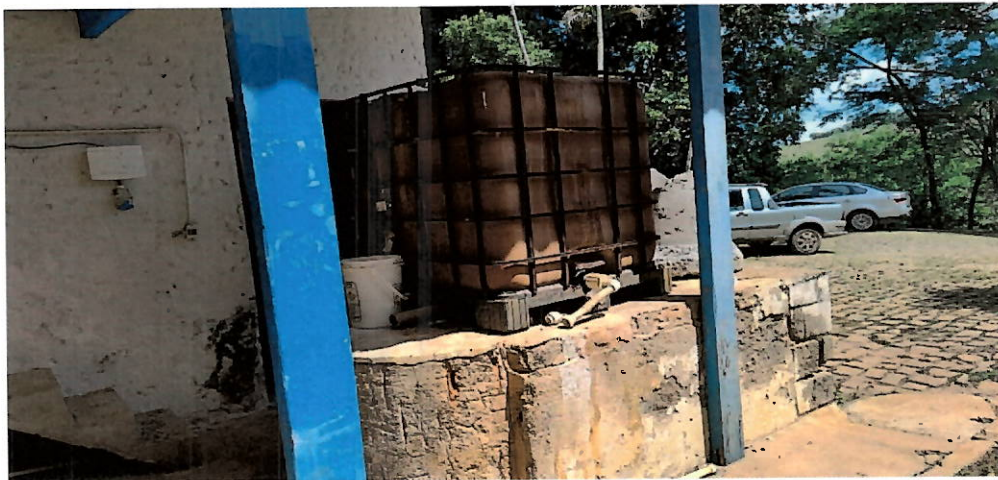
Foto 22: Armazenamento de Sulfato de Alumínio.
