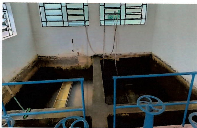
Foto 12: Dois filtros de areia de fluxo descendente.
