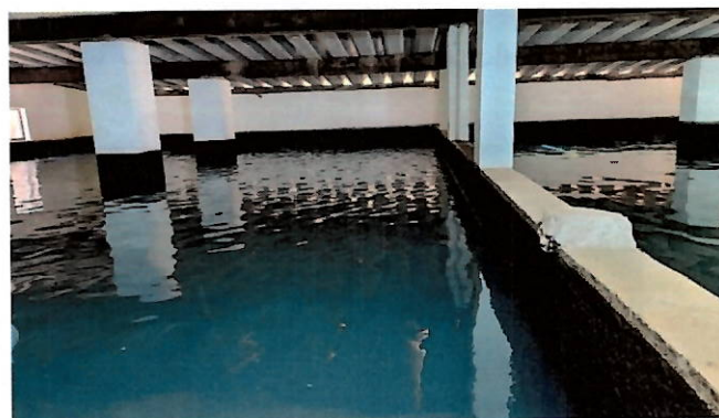
Foto 15: Vista interna do reservatório.
