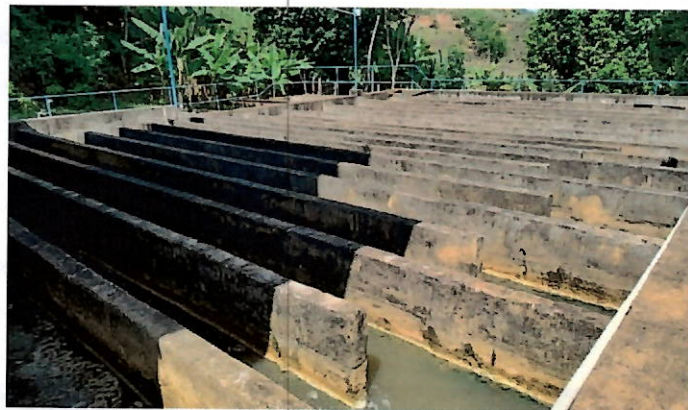
Foto 10: Floculador do tipo chicanas.
