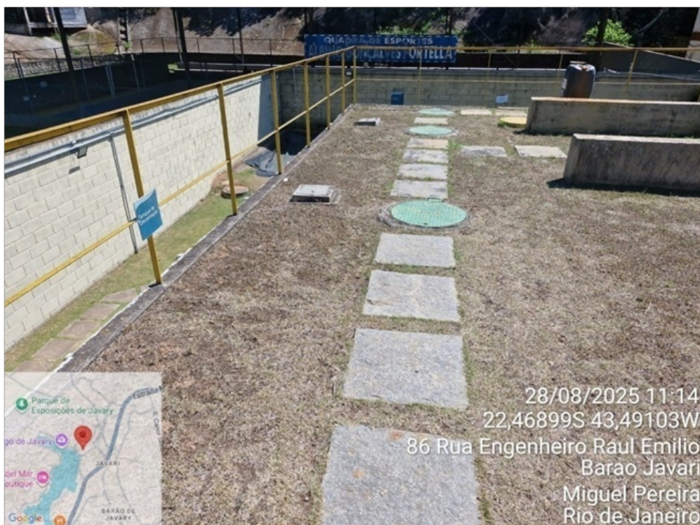
Foto 13 – Laje superior do Módulo 2
