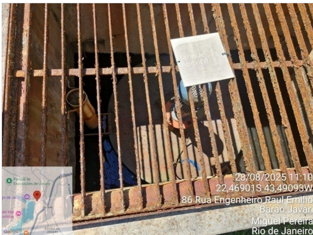
Foto 15 – Tanque anóxico com grade enferrujada
