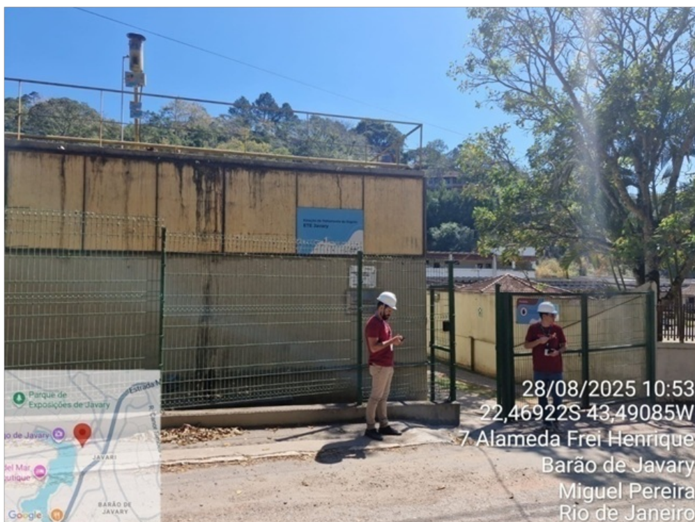
Foto 1 – Entrada da ETE
