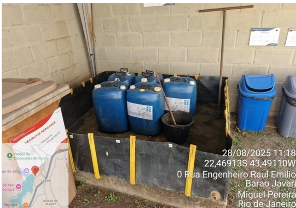
Foto 22 – Bacia de contenção
