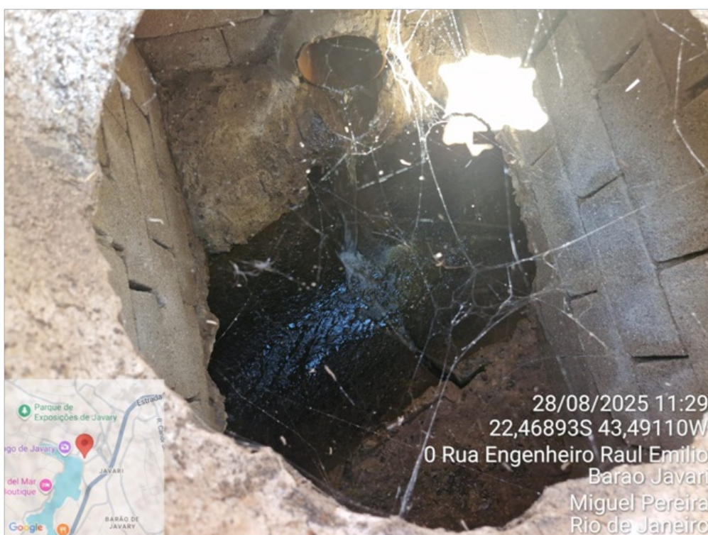
Foto 32 – Galeria de Águas Pluviais onde é encaminhado o efluente tratado
