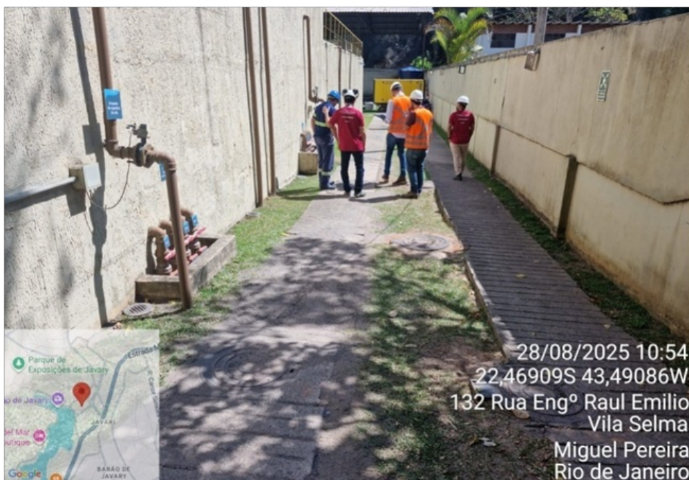
Foto 2 – Vista lateral esquerda da ETE
