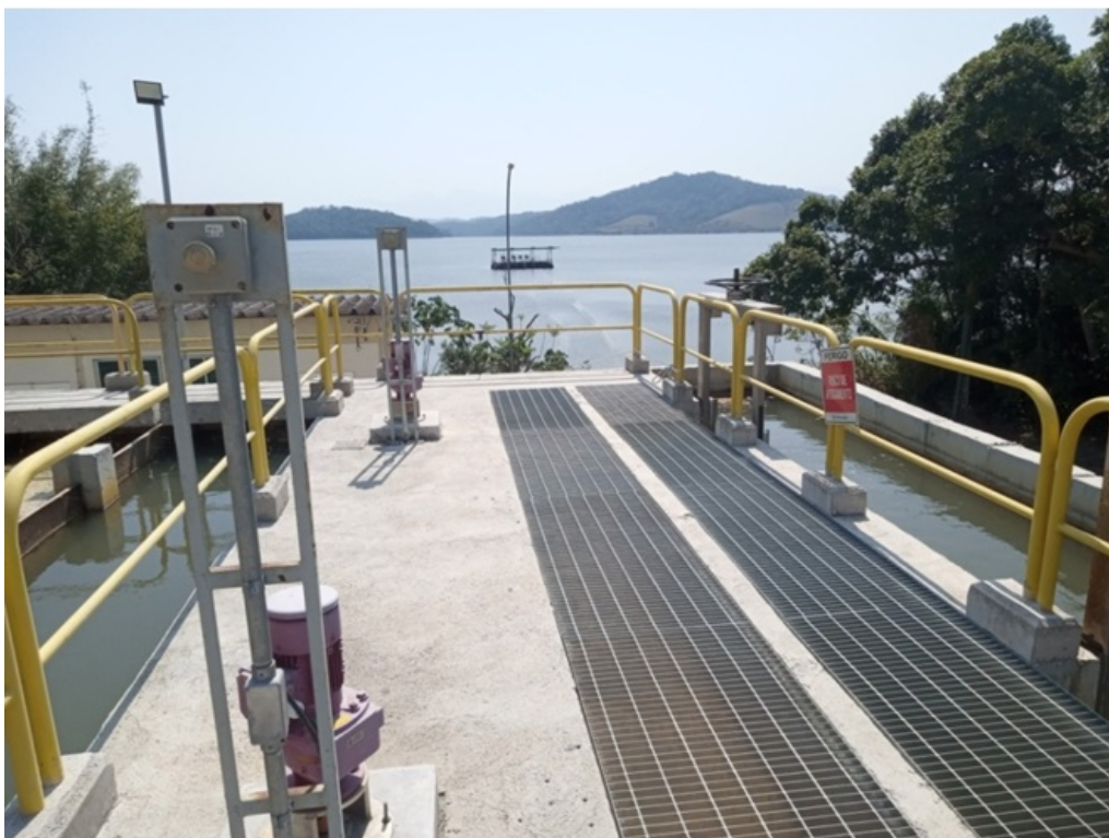
Balsa de Captação ao fundo
