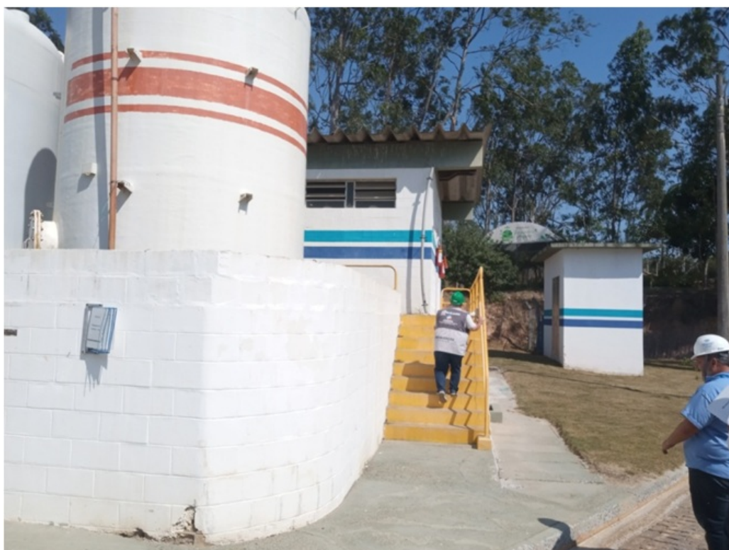
Local de armazenagem de produtos químicos
