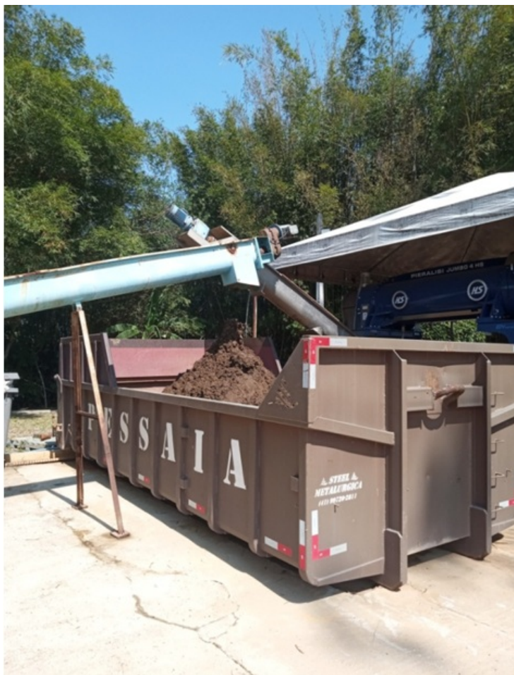
Caçamba de Armazenagem de lodo
