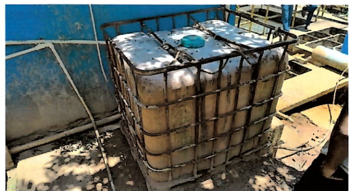
Foto 26: Sulfato de alumínio armazenado sem bacia de contenção, á céu aberto e sobre piso não impermeabilizado.
