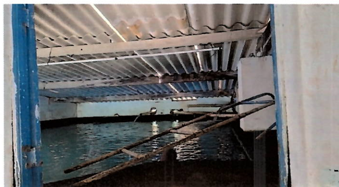
Foto 17: vista interna do reservatório.
