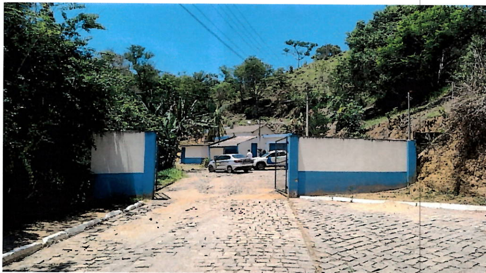
Foto 10: Entrada ETA. Nota-se a ausência da placa de identificação da ETA.
