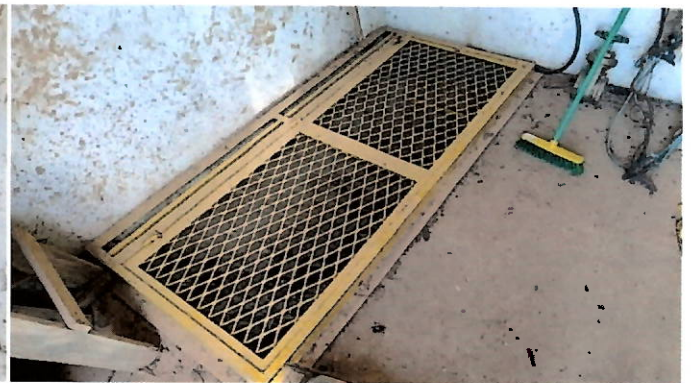
Foto 8: EEAB – poço de inspeção.
