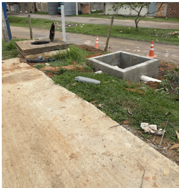
Foto 20 – PV (com a tampa levantada) de saída para a o lançamento. PV em construção (circuito para tratamento de remoção de nitrogênio).
