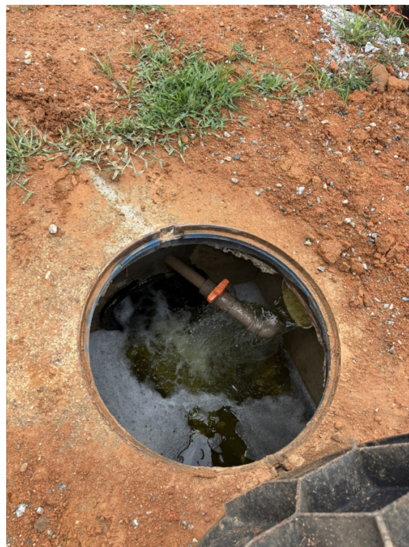
Foto 19 – Saída da terceira lagoa, onde há um tubo para captação para reúso
