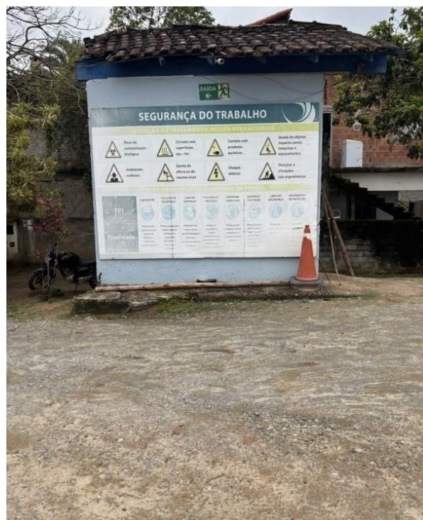
Foto 5 – Abrigo na entrada da ETE
