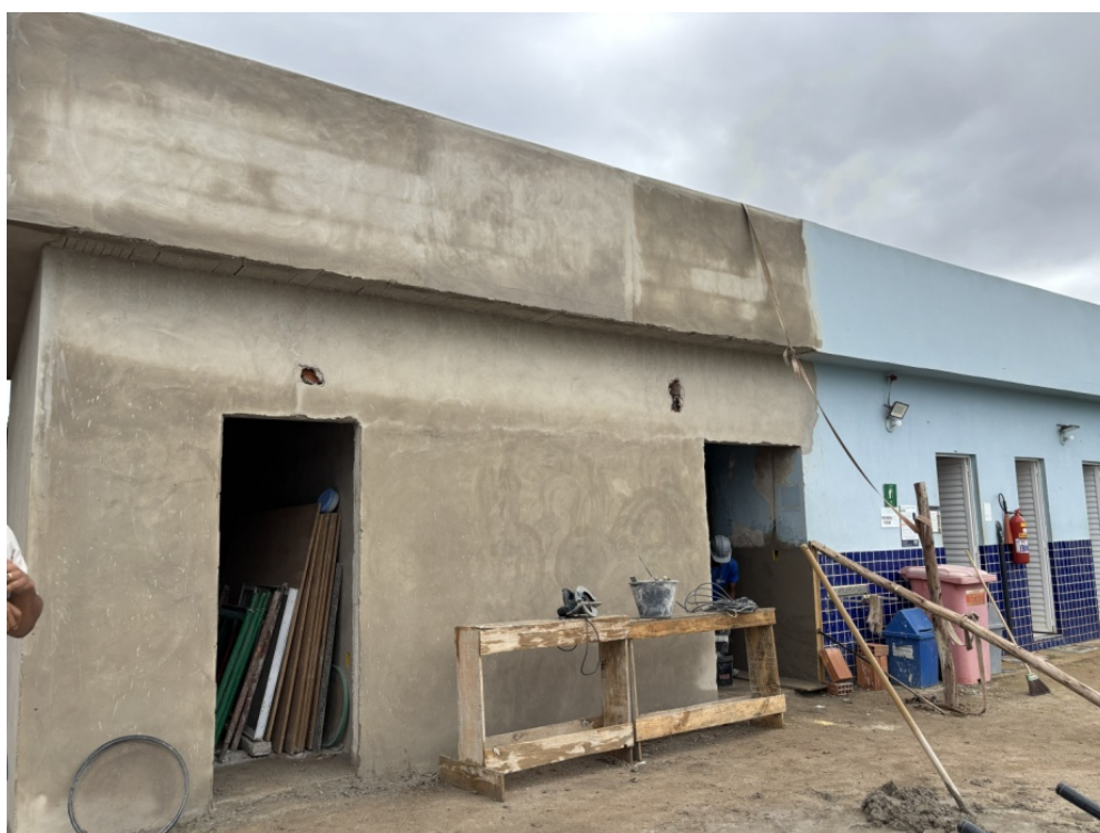
Foto 6 – Ampliação das salas de operação
