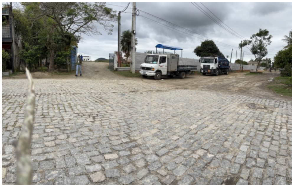
Foto 4 – Entrada da ETE Caju
