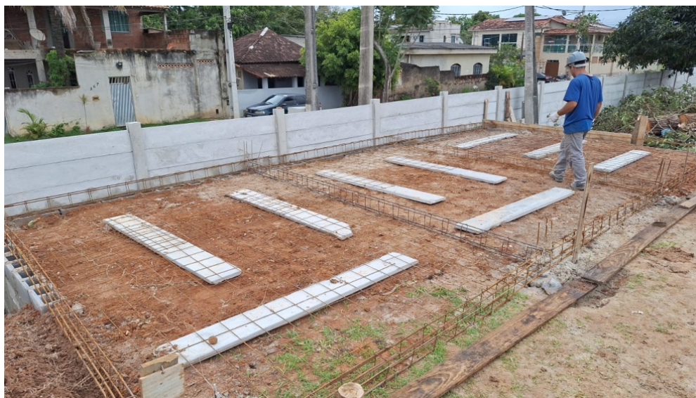
Foto 21 – Obra de construção do sistema de remoção de nitrogênio
