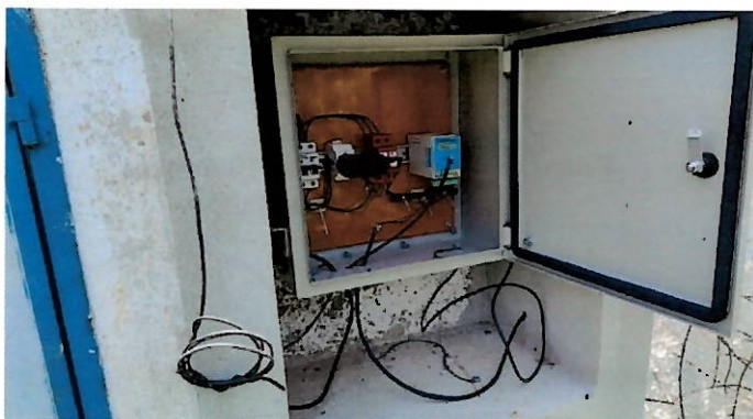
Foto 30: Controle de nível automático.
