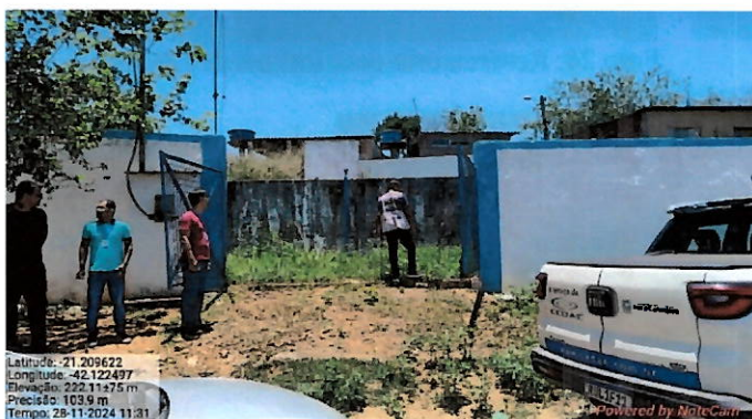
Foto 26: Entrada do Reservatório.
