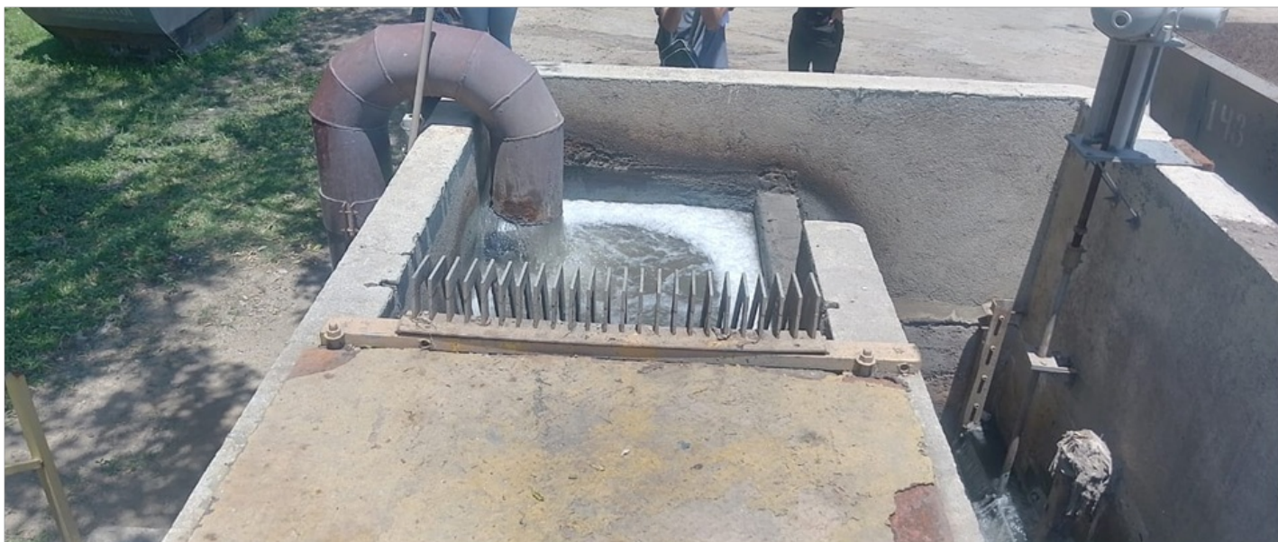
Foto 2 - Entrada afogada do recalque de esgoto bruto
