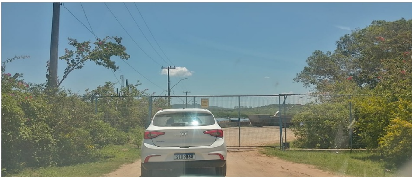
Foto 1- Entrada da Estação de Tratamento de Esgoto Jardim Esperança
