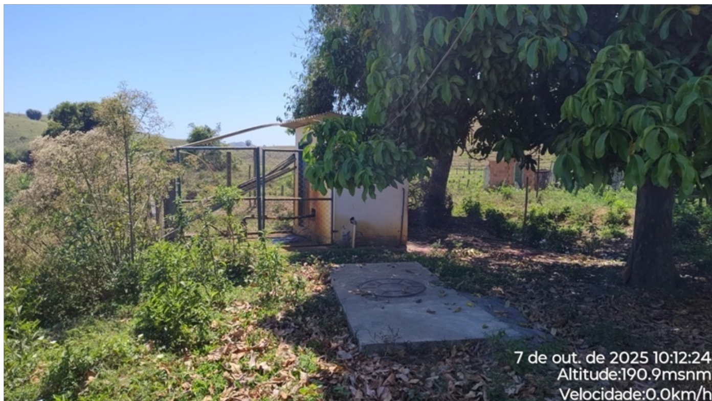
Foto 02: Abrigo do PCO com restrição de acesso.
