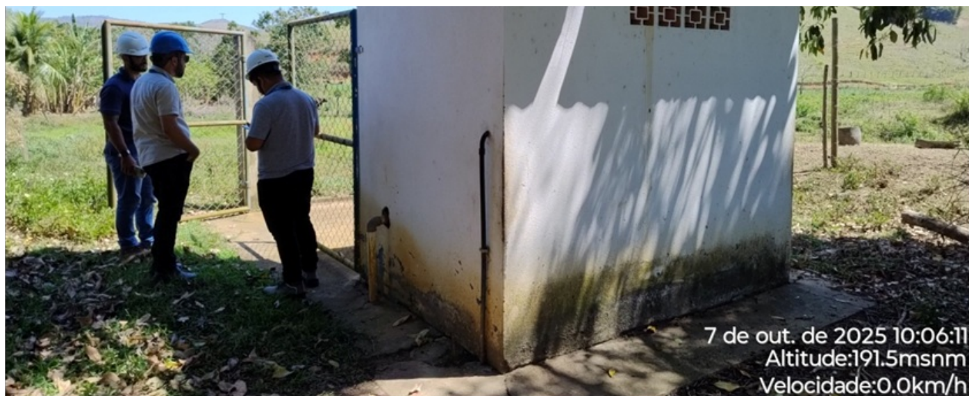
Foto 04: Abrigo do PCO.
