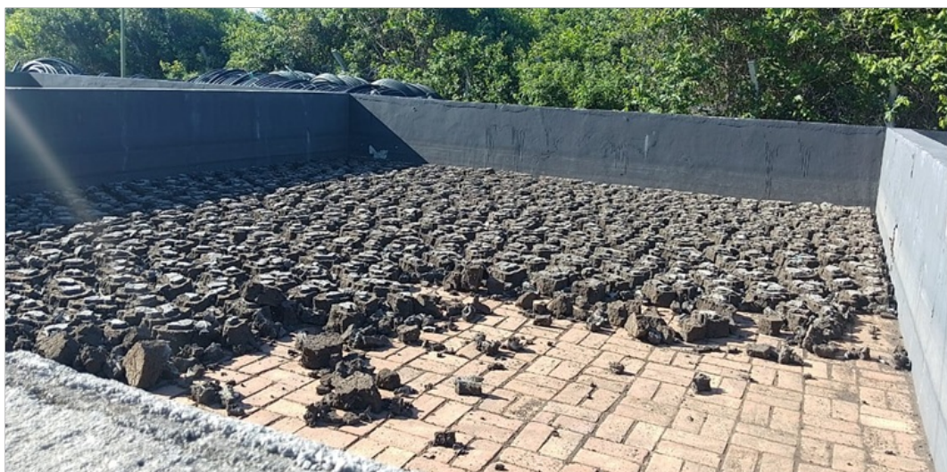
Foto 11 – Tanque de Leito de Secagem
