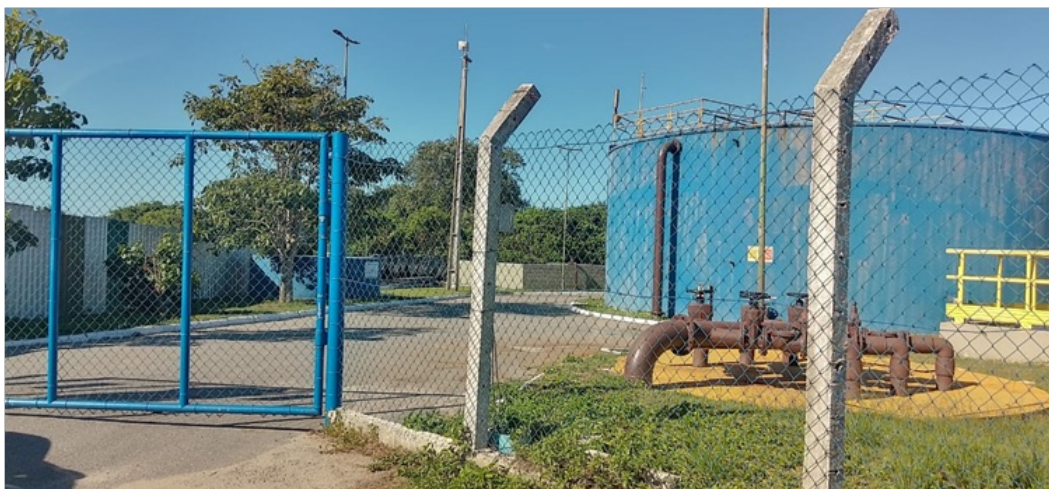
Foto 1- Entrada da Estação de Tratamento de Esgoto Monte Alto
