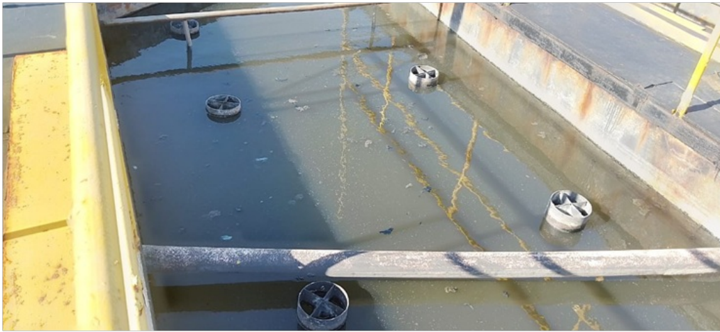
Foto 4 - Tanques Reatores UASB
