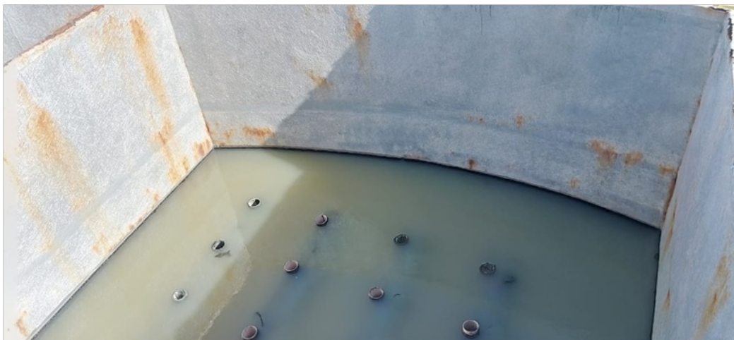
Foto 5 - Tanques de Decantadores Secundários
