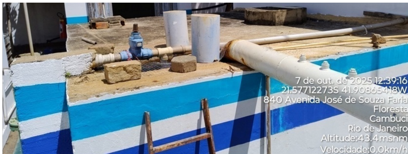
Foto 13: Câmara de contato.
