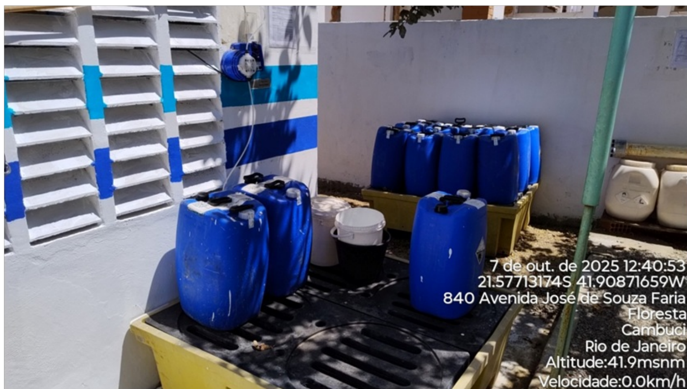
Foto 18: Dosador de ácido fluossilícico.
