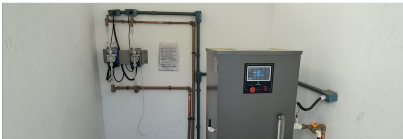
Foto 18: Dosador de ácido fluossilícico.
