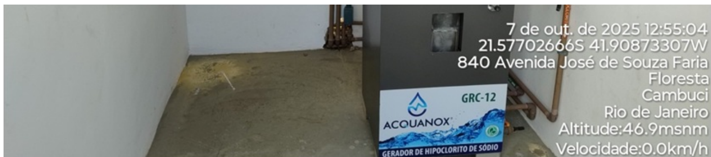
Foto 19: Equipamento de produção do Hipoclorito de sódio.
