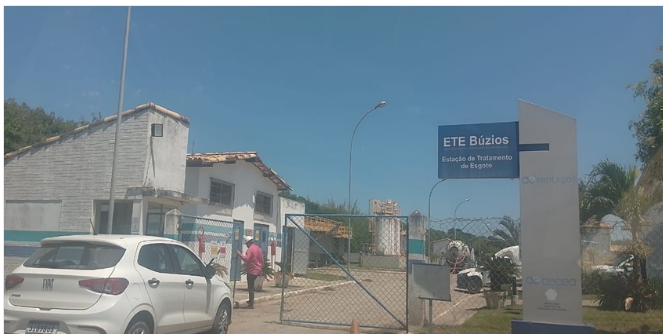
Foto 1- Entrada da Estação de Tratamento de Esgoto Búzios.
