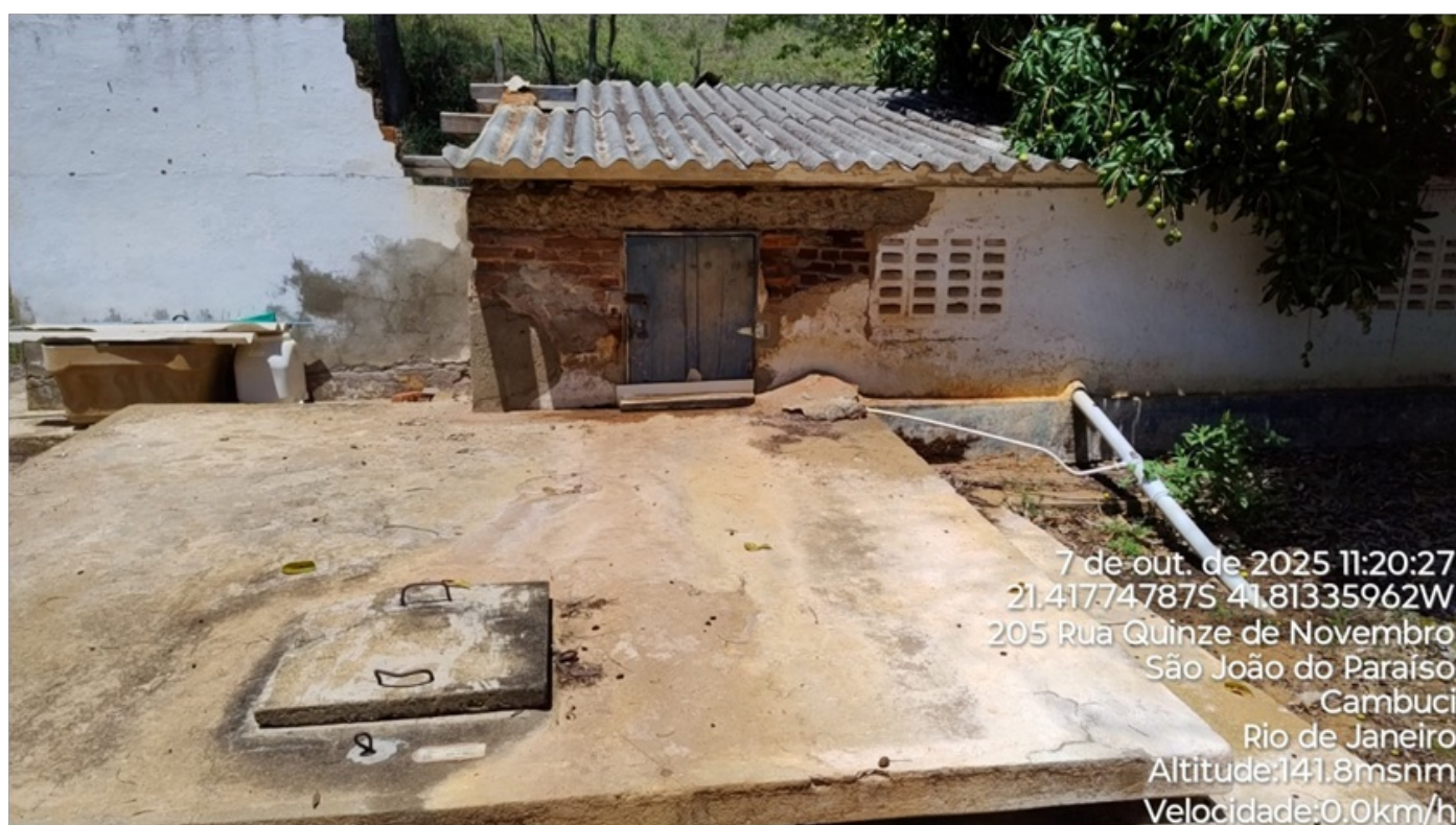
Foto 04: Vista frontal da estrutura do reservatório.
