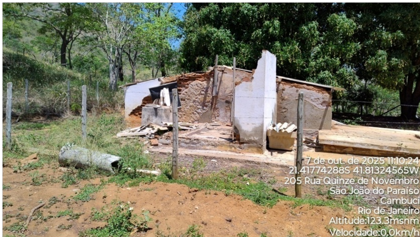
Foto 02: Vista lateral do abrigo do reservatório.
