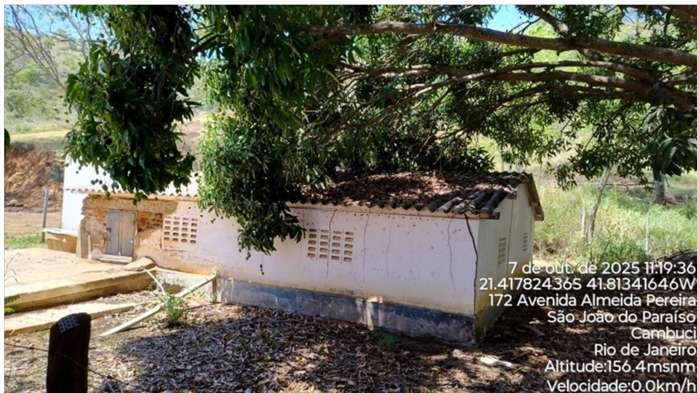
Foto 03: Vista lateral do abrigo do reservatório.
