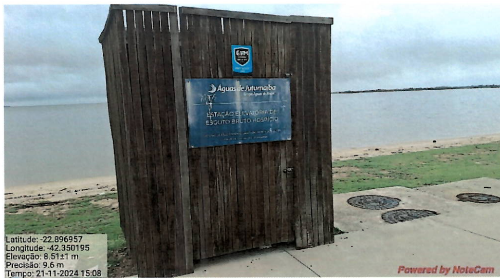
Foto 30 – Fachada abrigo quadros de comando
