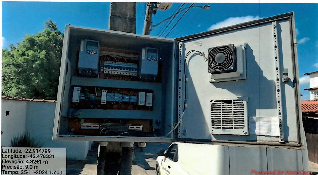
Foto 88 – Inversor de frequência e demais equipamentos automação e telemetria
