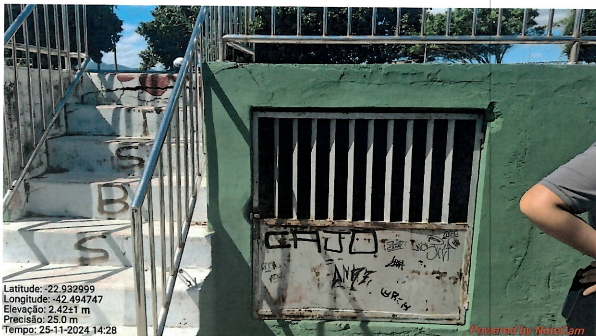
Foto 83 – Acesso ao poço de sucção
