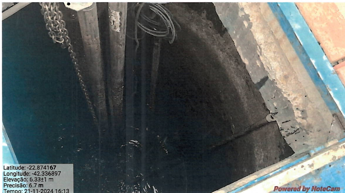
Foto 21 – Haste com sensor de nível
