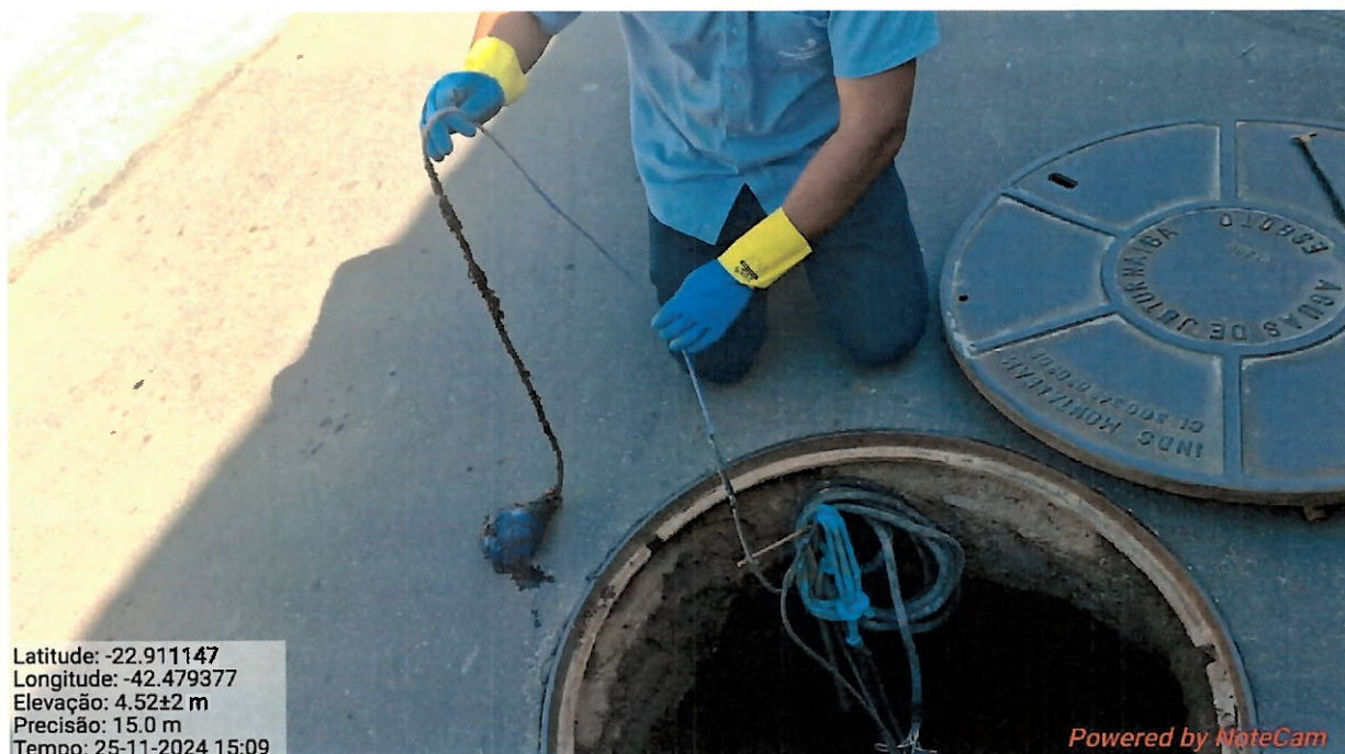
Foto 93 – Sensor de nível tipo bóia
