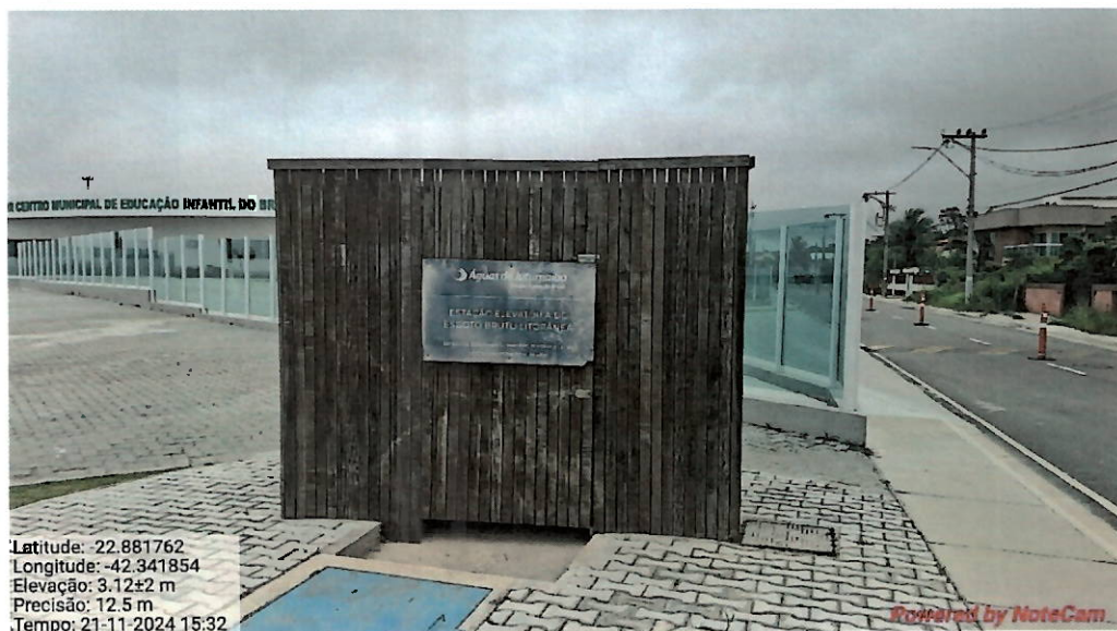
Foto 33– Fachada abrigo quadros de comando
