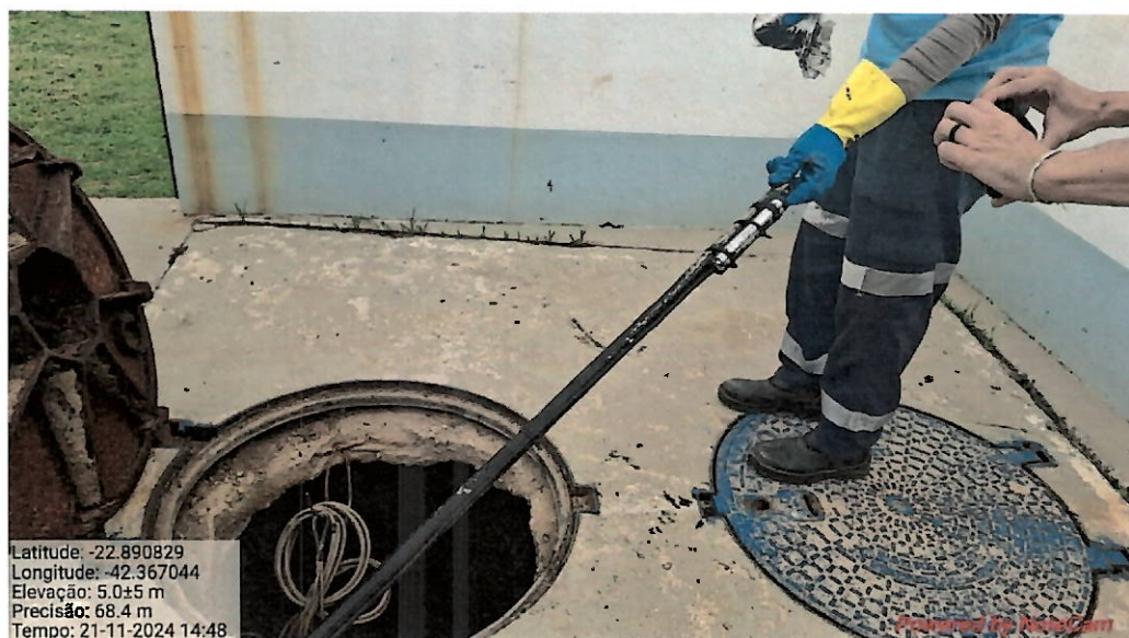
Foto 05 – Sensor medidor de nível
