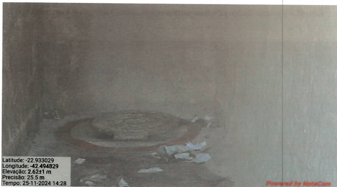
Foto 84 – Poço de sucção
