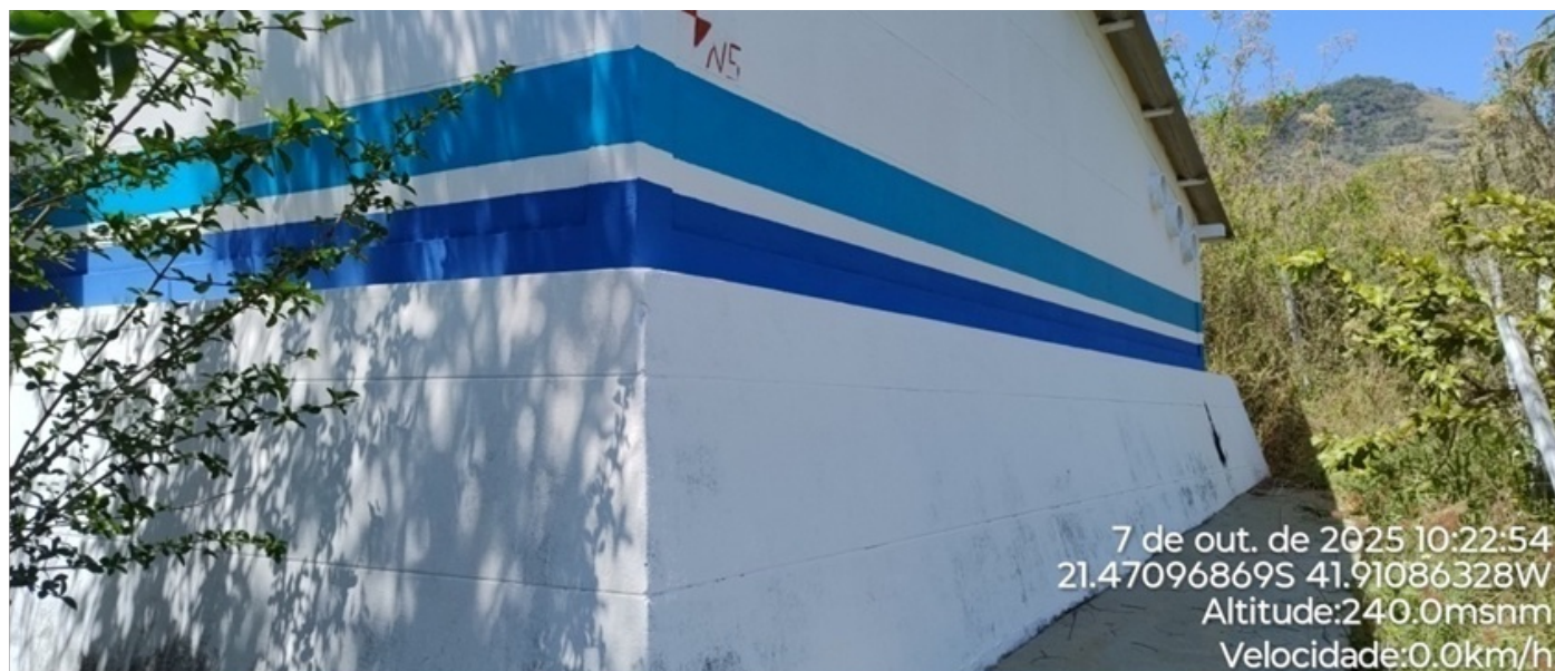
Foto 04: Vista lateral do reservatório.
