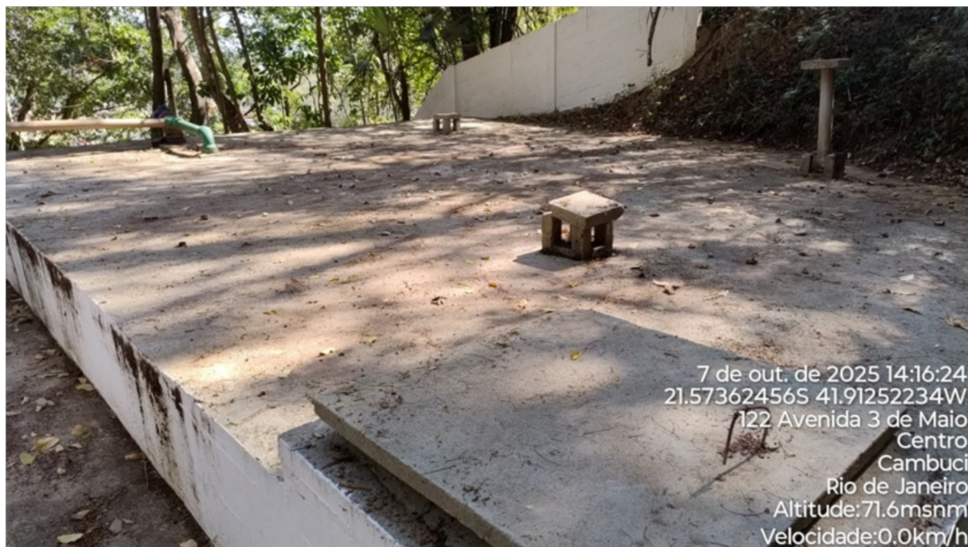
Foto 06: Cobertura do reservatório e respiros de ar.
