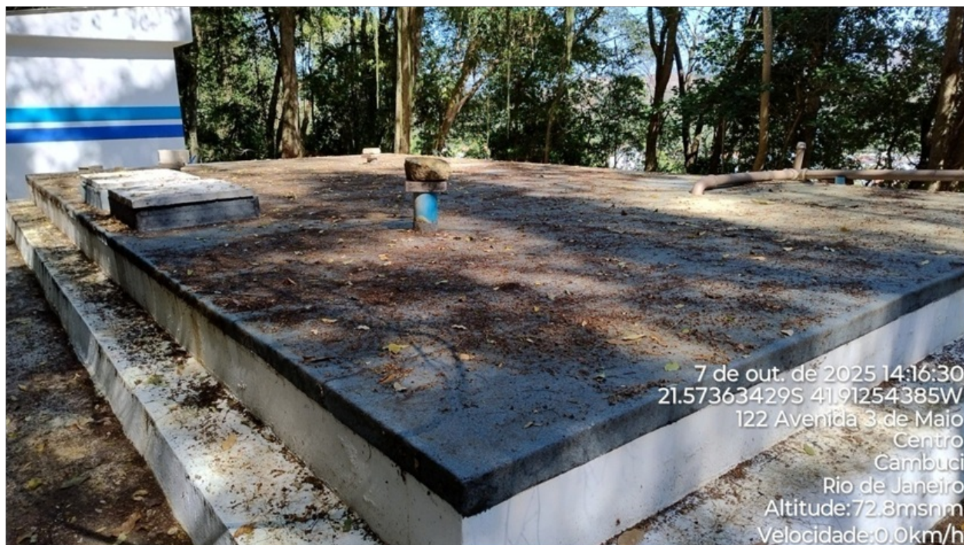
Foto 07: Cobertura do reservatório apresentava os respiros de ar bloqueados.
