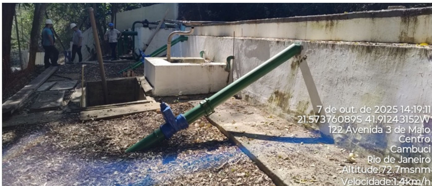
Foto 04: Vista do reservatório.
