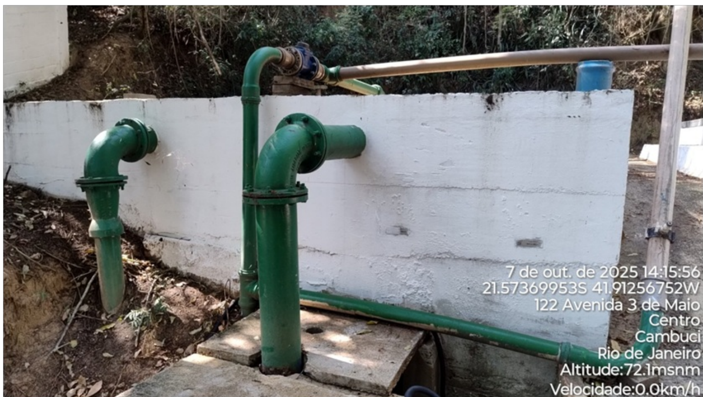
Foto 05: Vista do reservatório.
