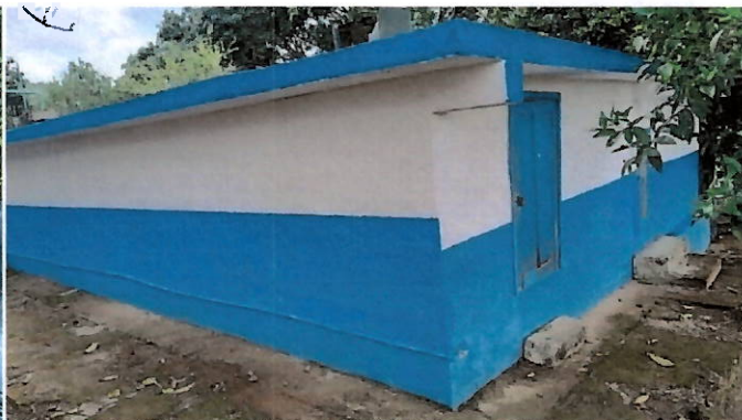
Foto 18: Vista lateral do reservatório.
