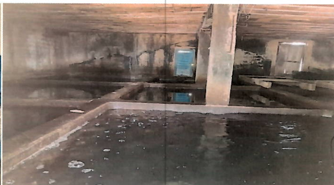
Foto 16: interior do reservatório (120 m 3 ).
