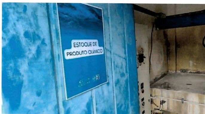
Foto 21: sala de estoque de produto químico.
