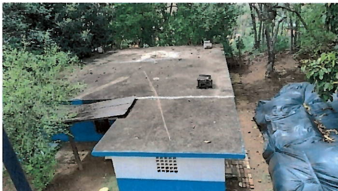
Foto 17: Vista superior do reservatório.
