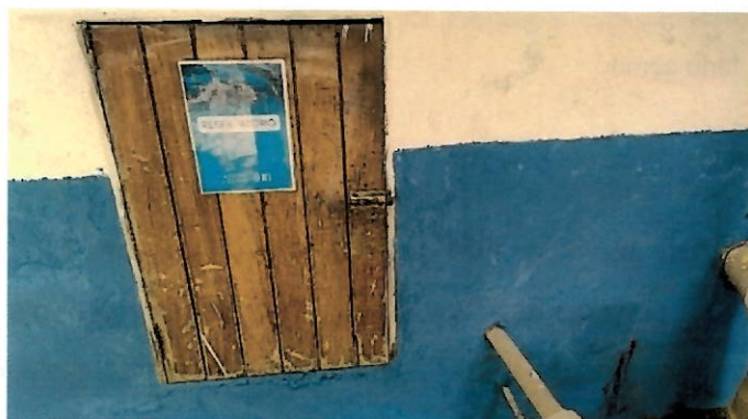
Foto 15: acesso ao reservatório.
