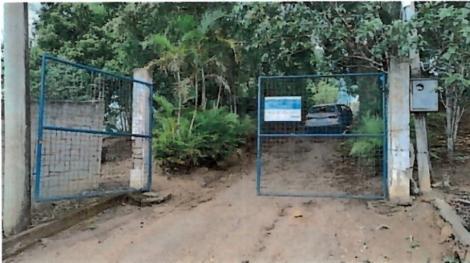
Foto 4: Entrada da ETA N. S. Aparecida.
