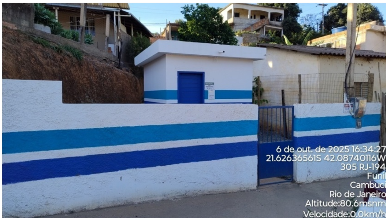
Foto 01- Abrigo da EEAT com restrição de acesso.
