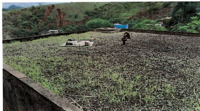
Foto 33: parte superior do reservatório.
