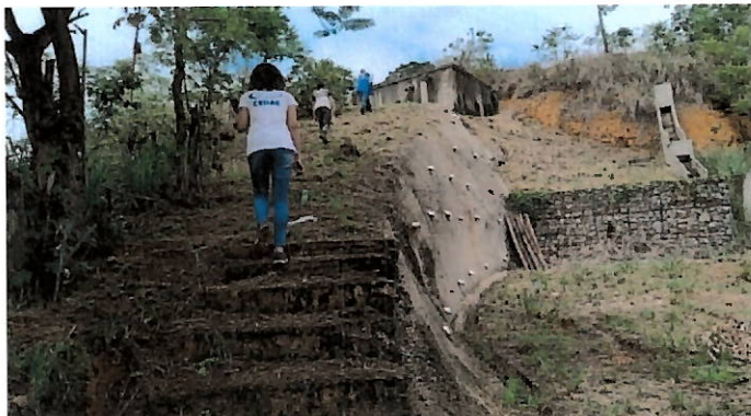
Foto 30: Escada de acesso ao reservatório.
