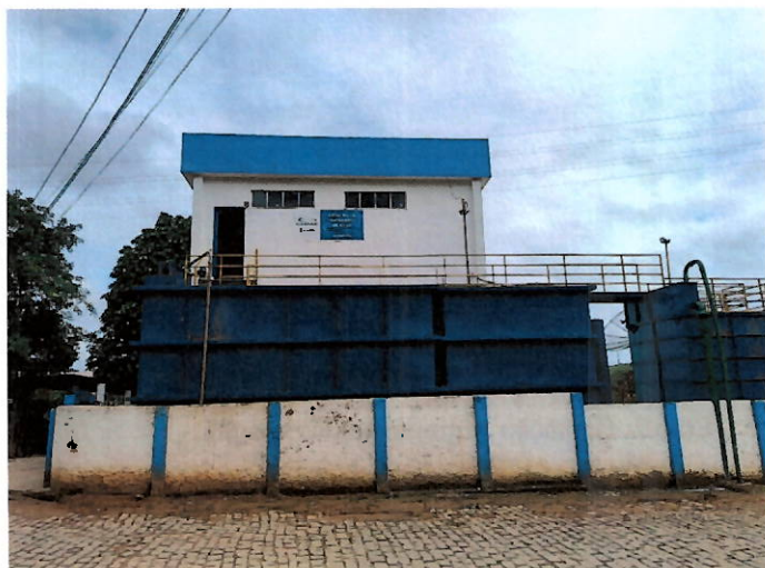
Foto 4: Fachada da ETA Jamapará.
