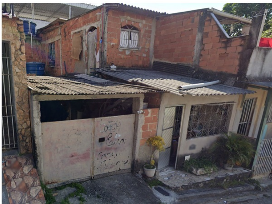
Foto 2 – Fachada frontal do imóvel nº 230 com hidrômetro no passeio
