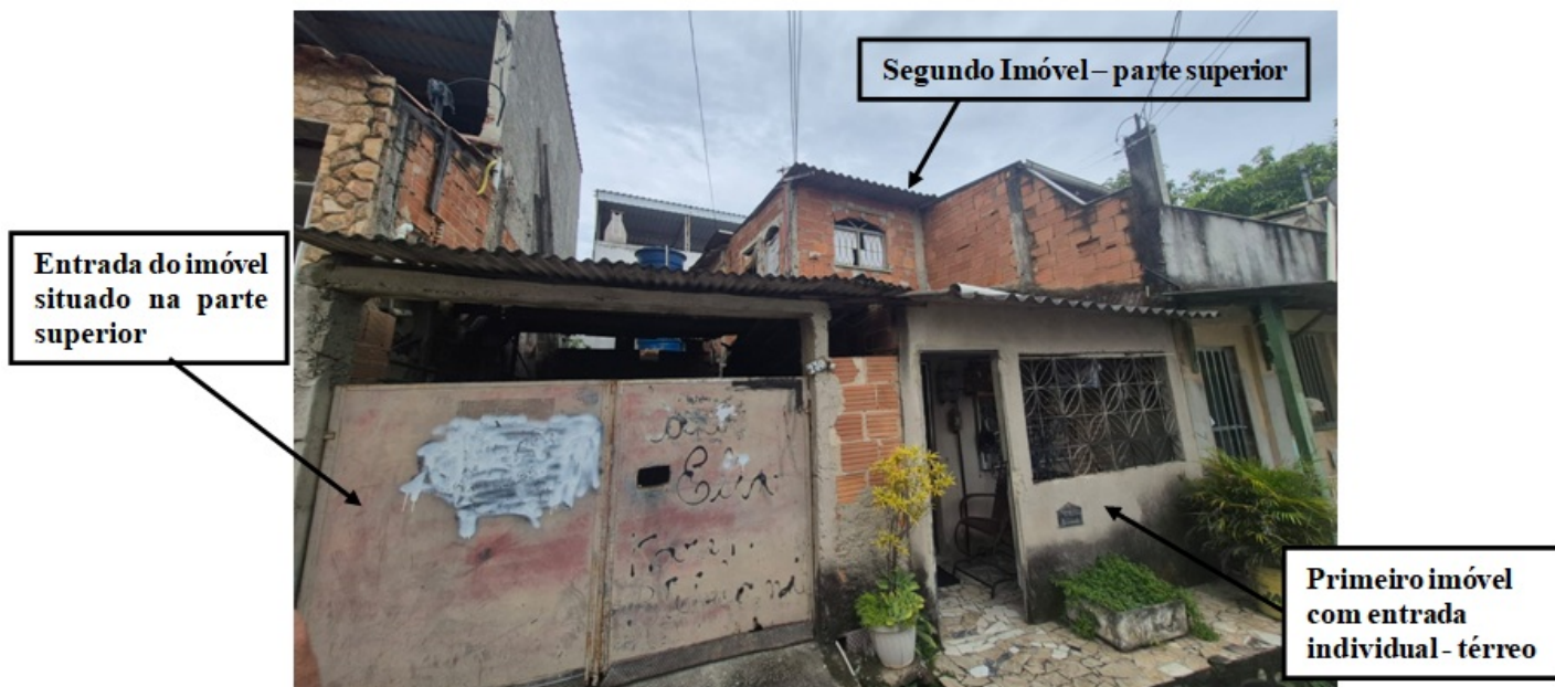
Foto 1 – Fachada frontal do imóvel nº 230
