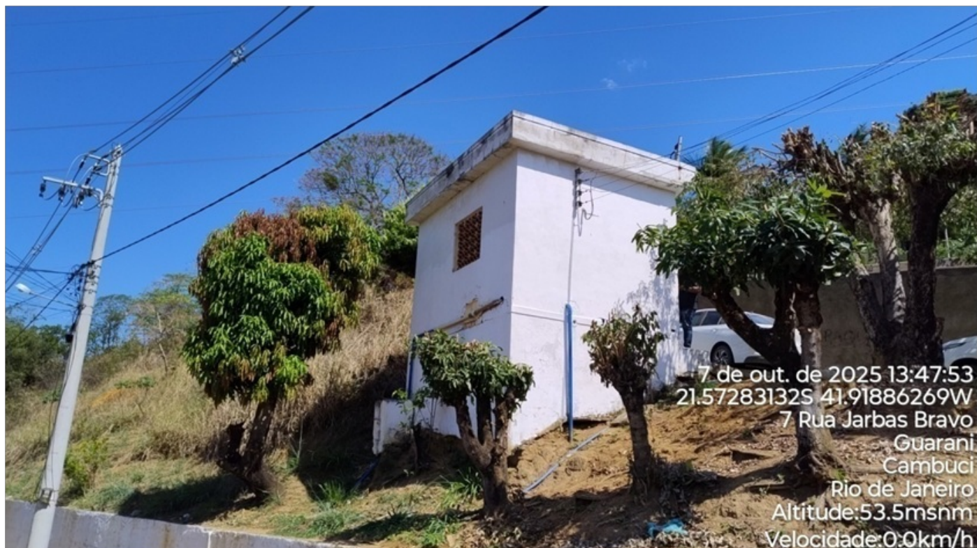
Foto 02 - Abrigo da EEAT.
