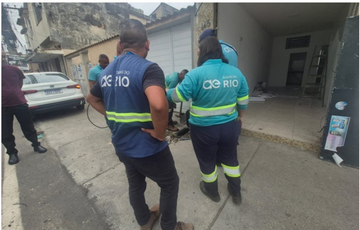
Foto 10 – Equipe da concessionária realizando o restabelecimento do abastecimento
