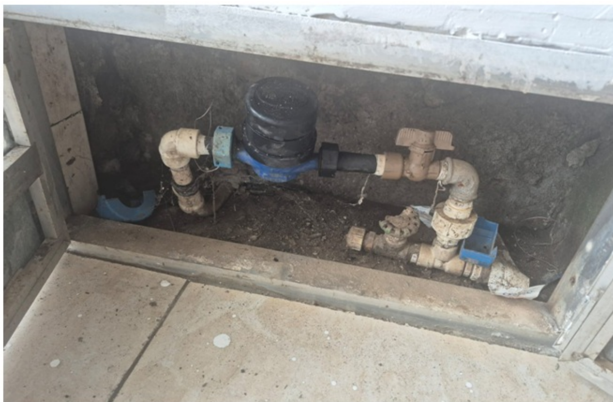
Foto 6 – Hidrômetro interno
