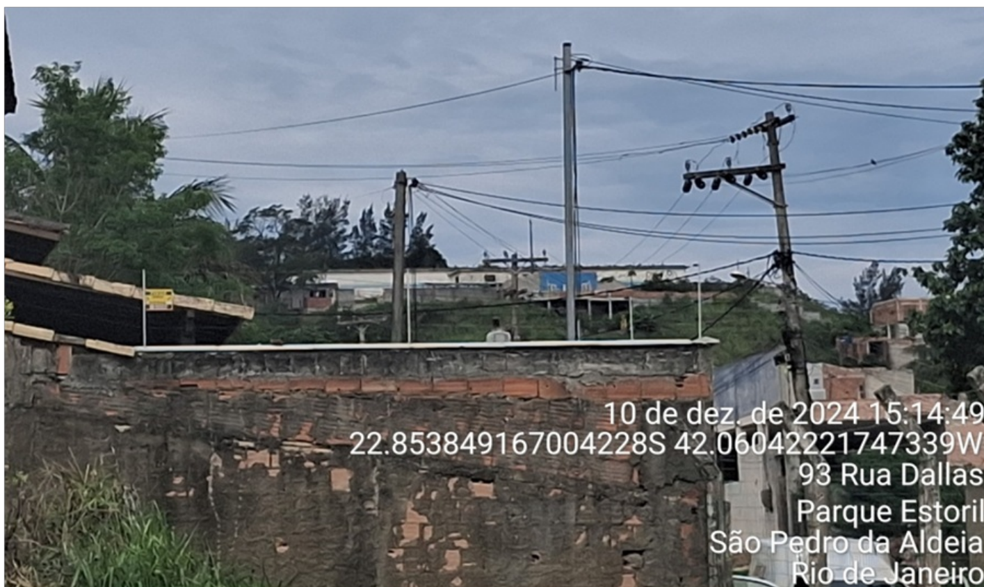
Foto 8 - Vista do RES que alimenta (pressurizada) o barrilete
