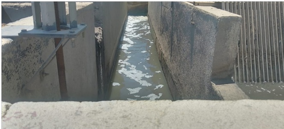
Foto 5 - Tratamento preliminar (gradeamento e desarenador)
