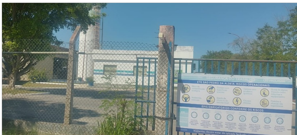
Foto 3 - Frente da ETE 14/12/2024 ( Portão e cerca no entorno)
