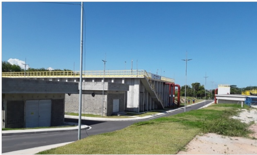
Foto 10 - Novos Tanques de aeração, aguardando início da operação
