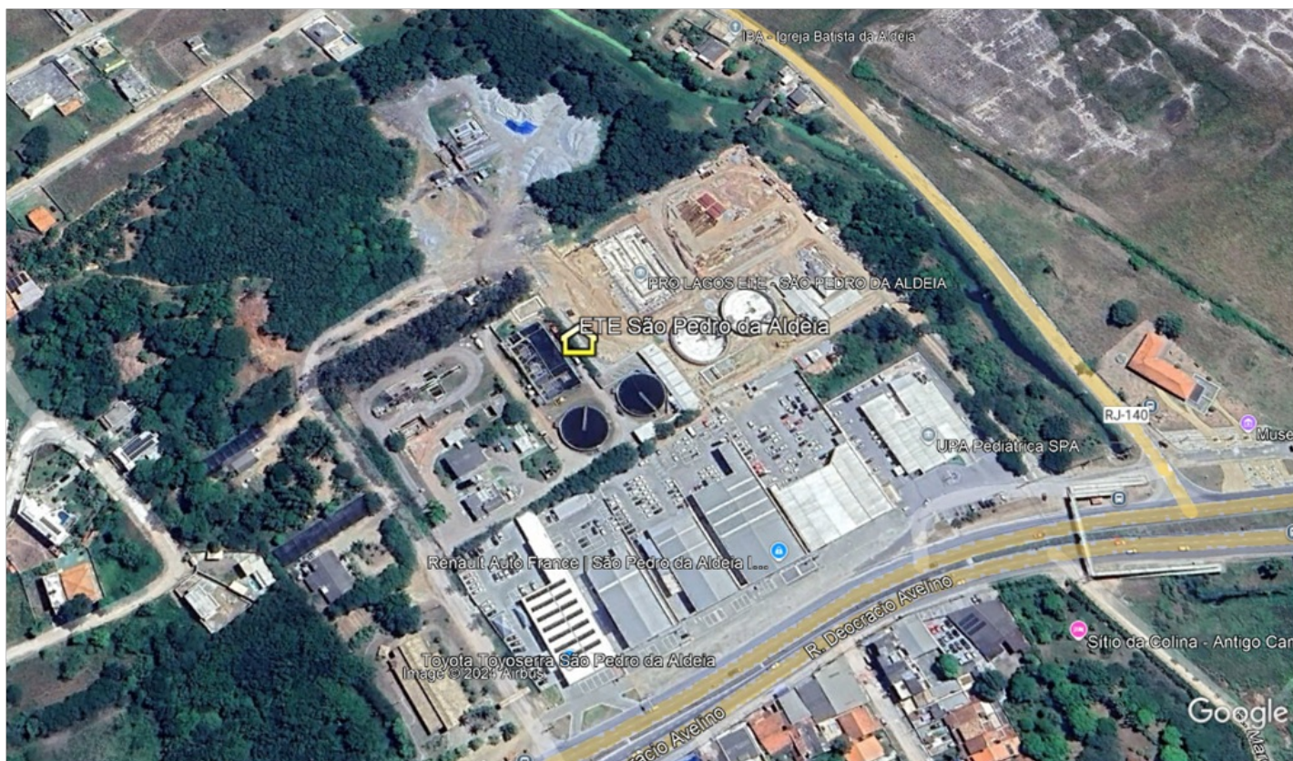
Foto 2 - Layout da ETE São Pedro da Aldeia, com unidades já concluídas na parte superior (dois novos decantadores, novo tanque de aeração, novo tratamento preliminar, nova EEE, novo tratamento do lodo).
