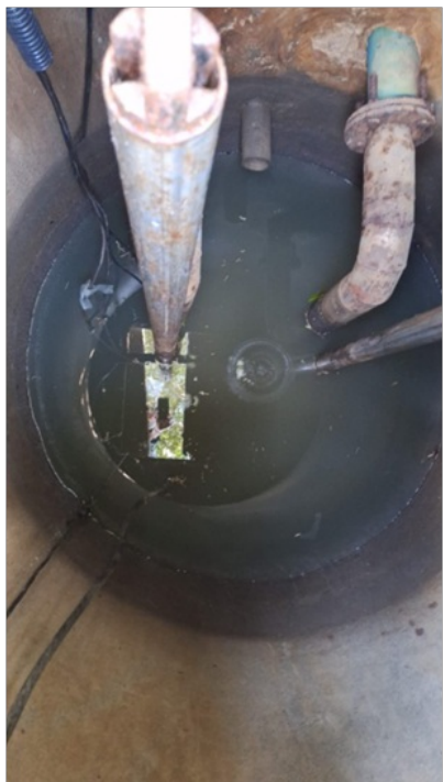
Foto 5 – Vista interna do poço da EEE Zebrinha com uma bomba.
