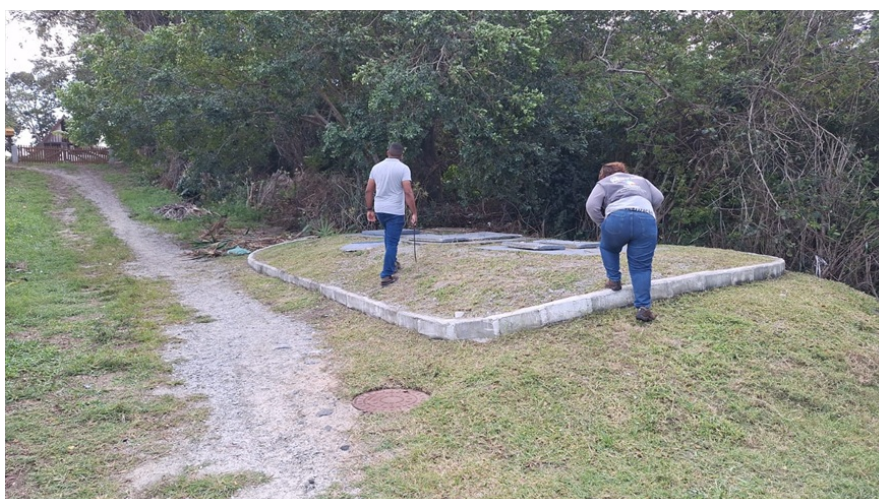
Foto 3 – Vista externa da EEE Zebirinha com o poço da bomba abaixo do portão de madeira.
