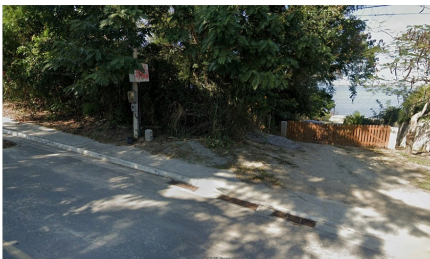
Fotos 2 – Vista externa da EEE Zebirinha com quadro elétrico e medidor em tela, o poço da bomba se encontra abaixo do portão de madeira.
