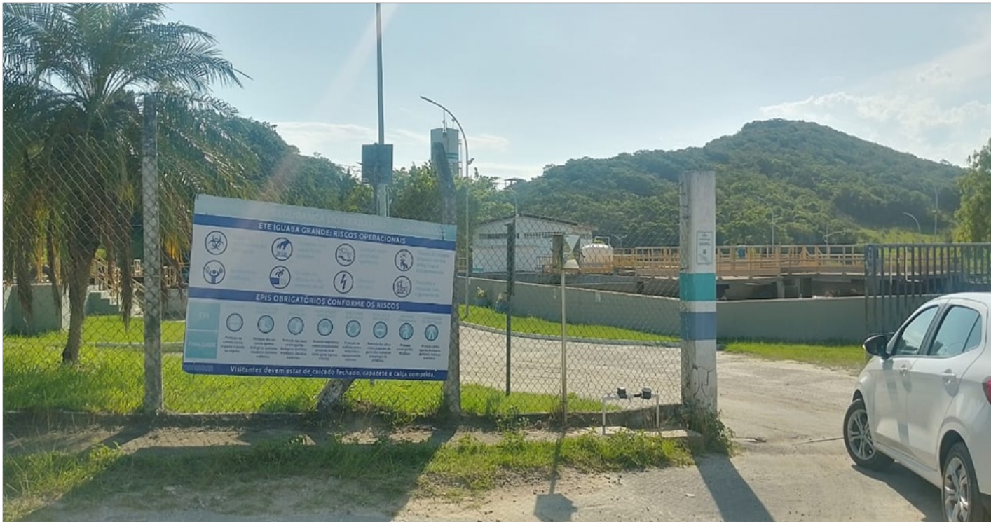
Foto 1- Entrada da Estação de Tratamento de Esgoto Iguaba Grande.
