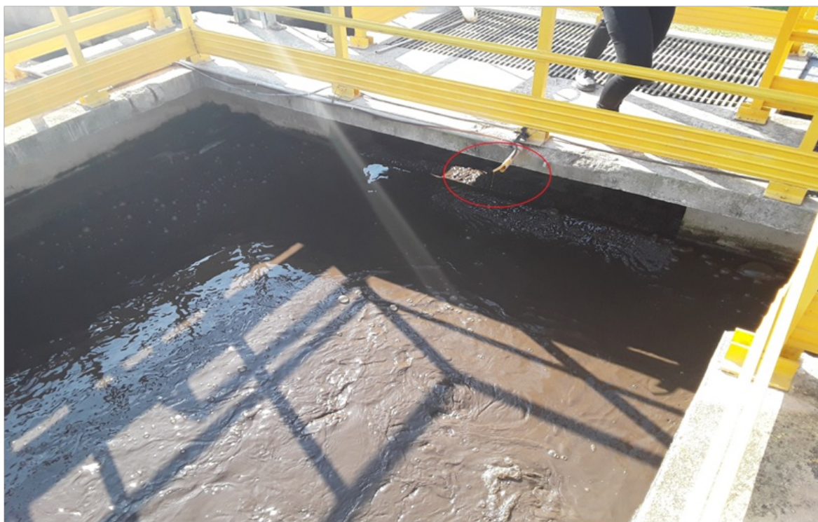
Foto 9- Ponto de aplicação do agente coagulante.
