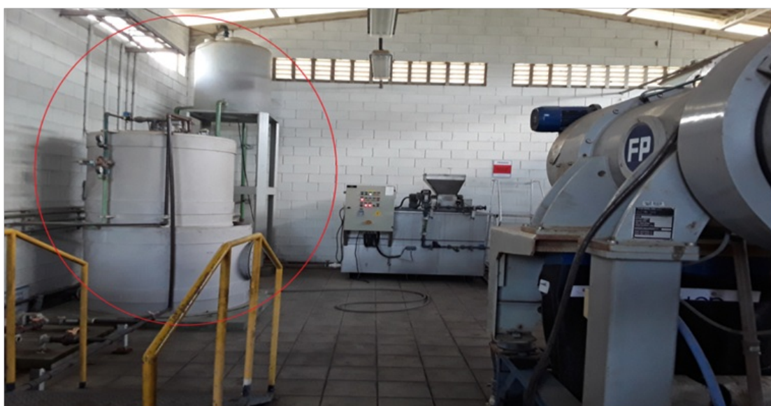
Foto 16- Armazenamento de Polímero para desidratação do lodo.
