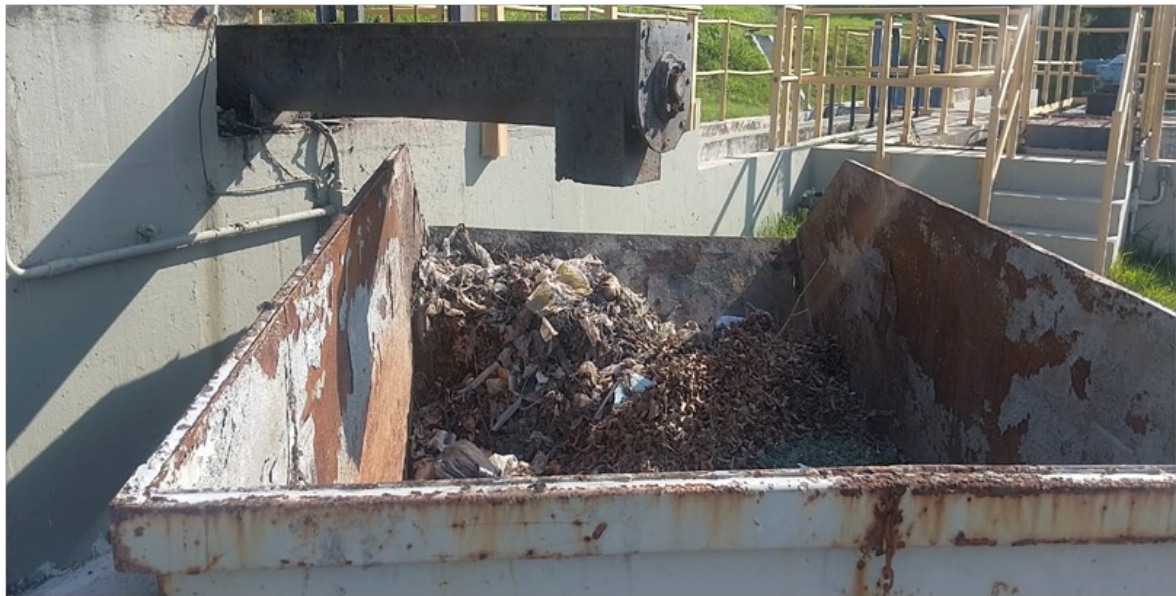
Foto 6- Caçamba para transporte de material grosseiro preliminar.
