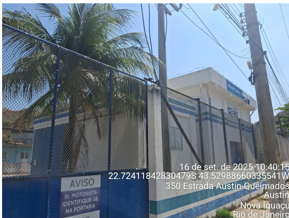
Foto 1: Fachada da EEAT.
