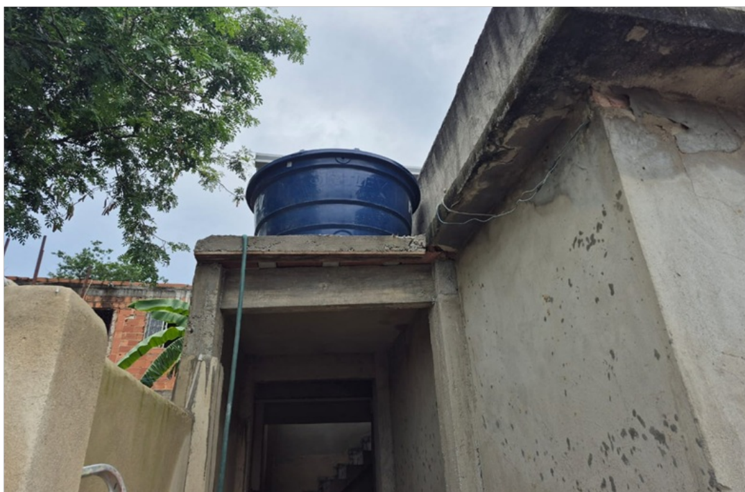
Foto 4 – Reservatórios superiores com altura aproximada de 8 metros, em relação ao logradouro
