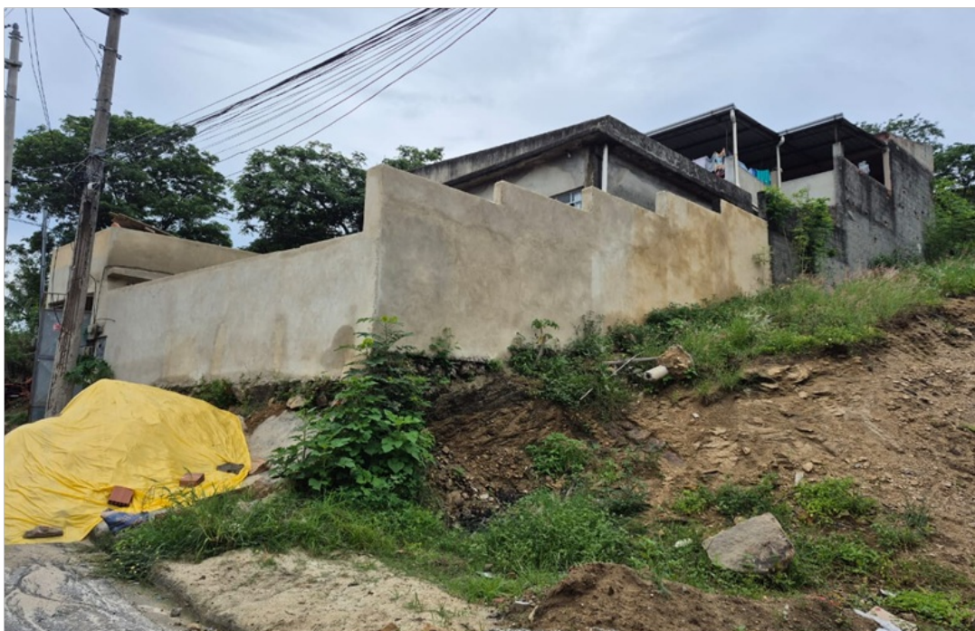
Foto 2 – Fachada lateral do imóvel
