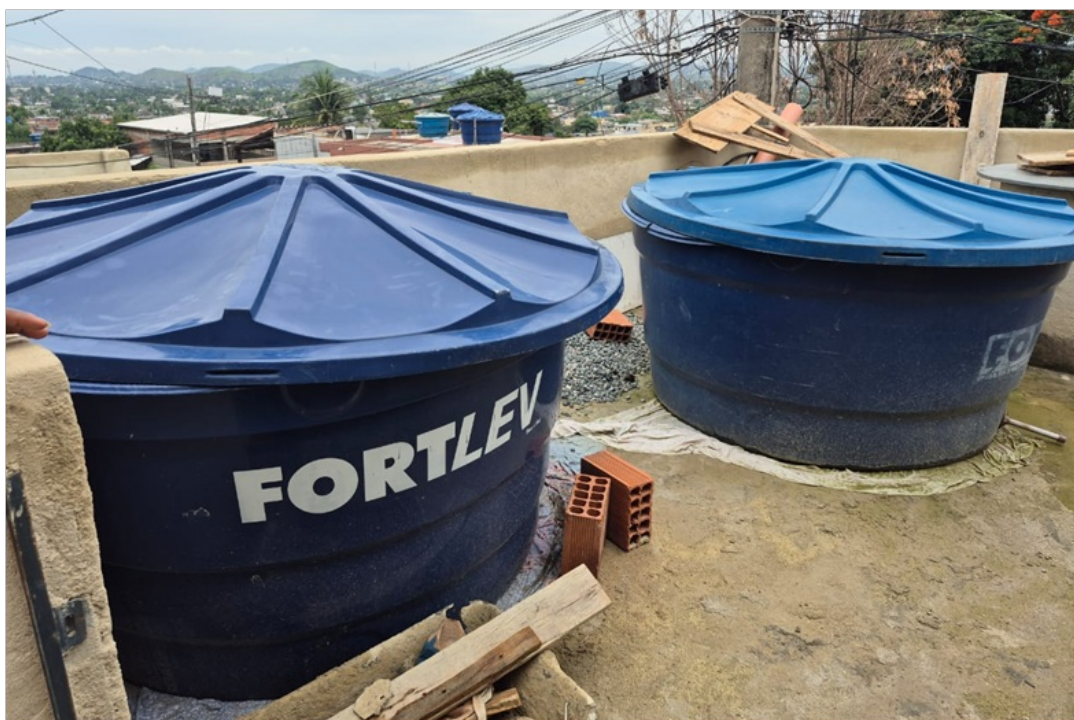
Foto 3 – Reservatórios superiores com altura aproximada de 4 metros, em relação ao logradouro
